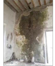
CU-01 | FILTRACION DE HUMEDAD EN PLAFONDES, COLONIZACION BIOLÓGICA Y ATAQUE XILOFAGO EN VIGUERÍA
