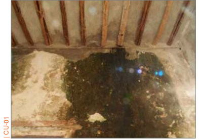
CU-01 | FILTRACION DE HUMEDAD EN PLAFONDES, COLONIZACION BIOLÓGICA Y ATAQUE XILOFAGO EN VIGUERÍA
