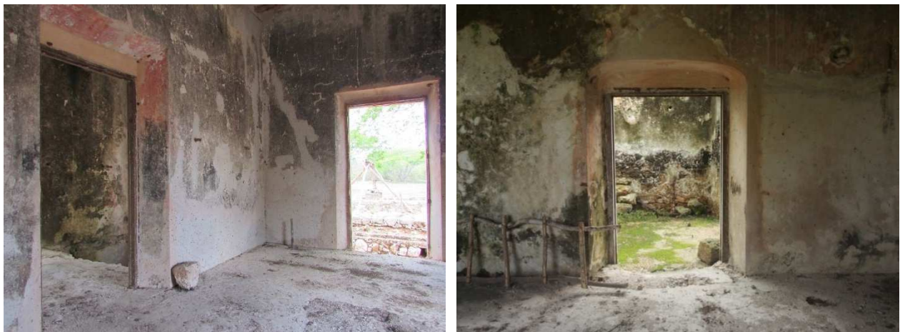
Figura 65. Tipos de cerramientos en la casa principal. Der. Arco de medio punto de la capilla. Fotografías: Autor, 2019.
