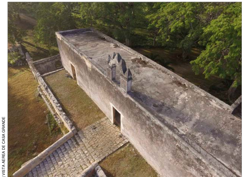
EROSIÓN / ABRACIÓN, FISURAS, AGRIETAMIENTO Y MICROORGANISMOS EN RECUBRIMIENTO DE AZOTEA SUCIEDAD POR DEPOSITO
