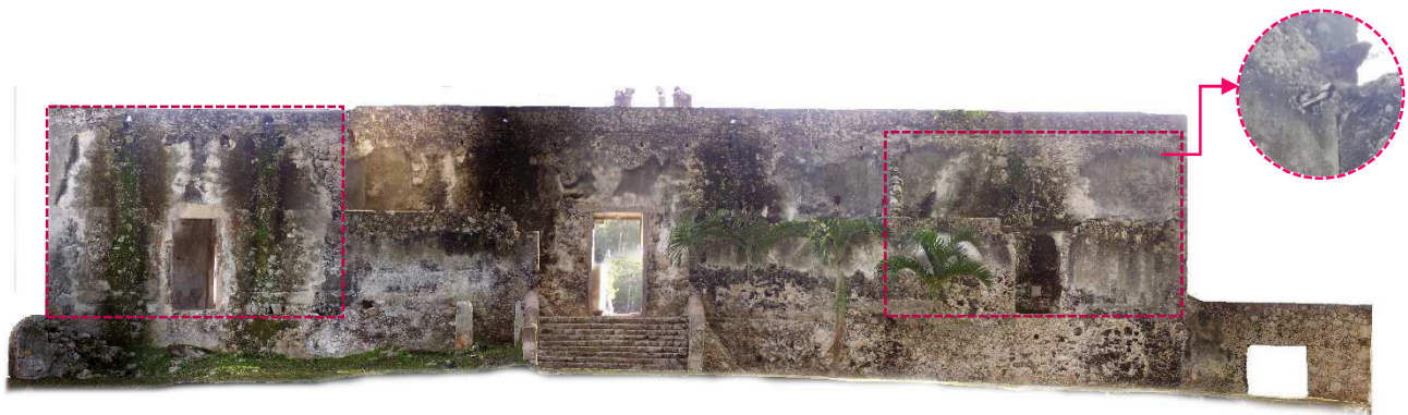
Figura 74. Fachada posterior de la casa principal, se puede observar en recuadros los cuartos cabeceros, y a un costado se remarca evidencias del sistema estructural empleado para resguardar al espacio. Ortofoto: Elaboración de ArqueoDroN, 2019.
