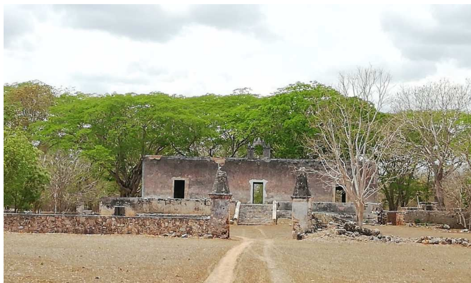
Figura 118. Vista Norte de c acceso a corrales y casa principal. Fotografía: Autor, 2019.
