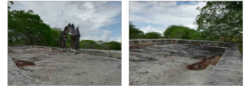
EROSIÓN / ABRACIÓN, FISURAS, AGRIETAMIENTO Y MICROORGANISMOS EN RECUBRIMIENTO DE AZOTEA SUCIEDAD POR DEPOSITO
