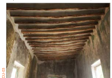
CU-03 | FILTRACION DE HUMEDAD EN PLAFONDES, COLONIZACION BIOLÓGICA Y ATAQUE XILOFAGO EN VIGUERÍA
