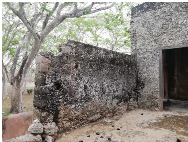
Figura 63. Izq. Muro de pórtico de acceso de la casa grande. Der. Detalle de pilastrón adosado a muro de mampostería de casa principal. Fotografías: Autor, 2019.
