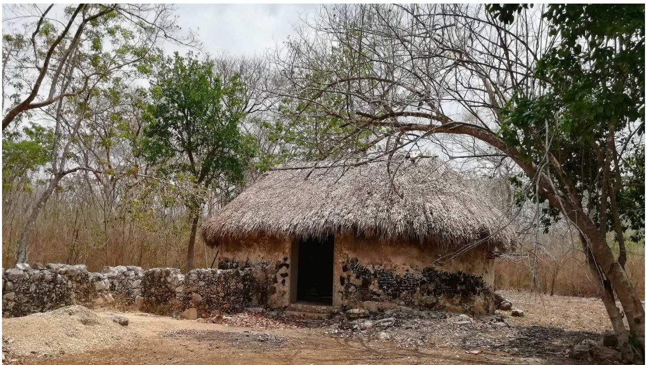
Figura 68. Vivienda Maya de muro de mampostería y techumbre de pajilla. Fotografía: Autor, 2019.
