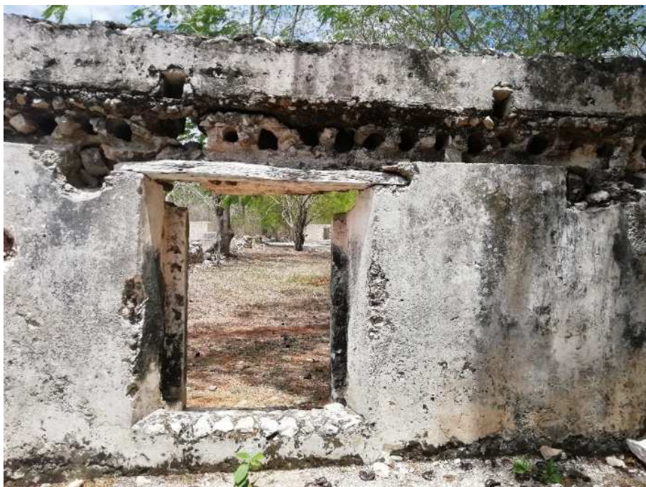
Figura 67. Arriba. Intervención de techumbre con rollizos de mala calidad sobre vigas de arrastre. Der. Detalle de huellas de techumbre de rollizos y bahpek. Fotografía: Autor, 2019.
