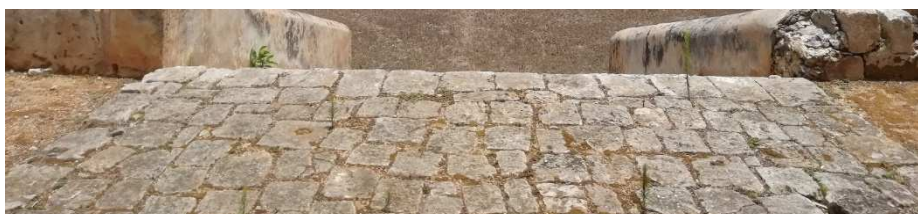
Figura 70. Arriba. Piso de estuco del interior de la casa principal. Abajo. Piso de mampuestos en pórtico de acceso de la casa principal. Fotografía: Autor, 2019.
