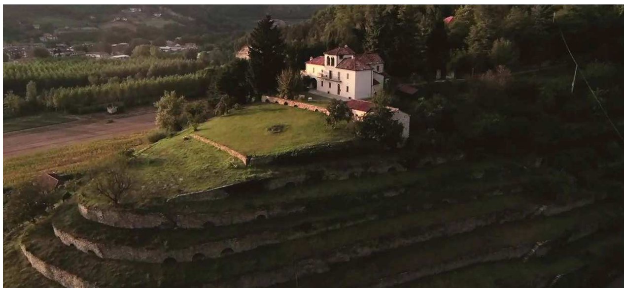
Figura 90. Viñedos y Cascina Monteoliveto, en terrazas de Valle de Bormida en Alta Langa. Fuente: PAgina oficial de Facebook Cascina Monteoliveto.
