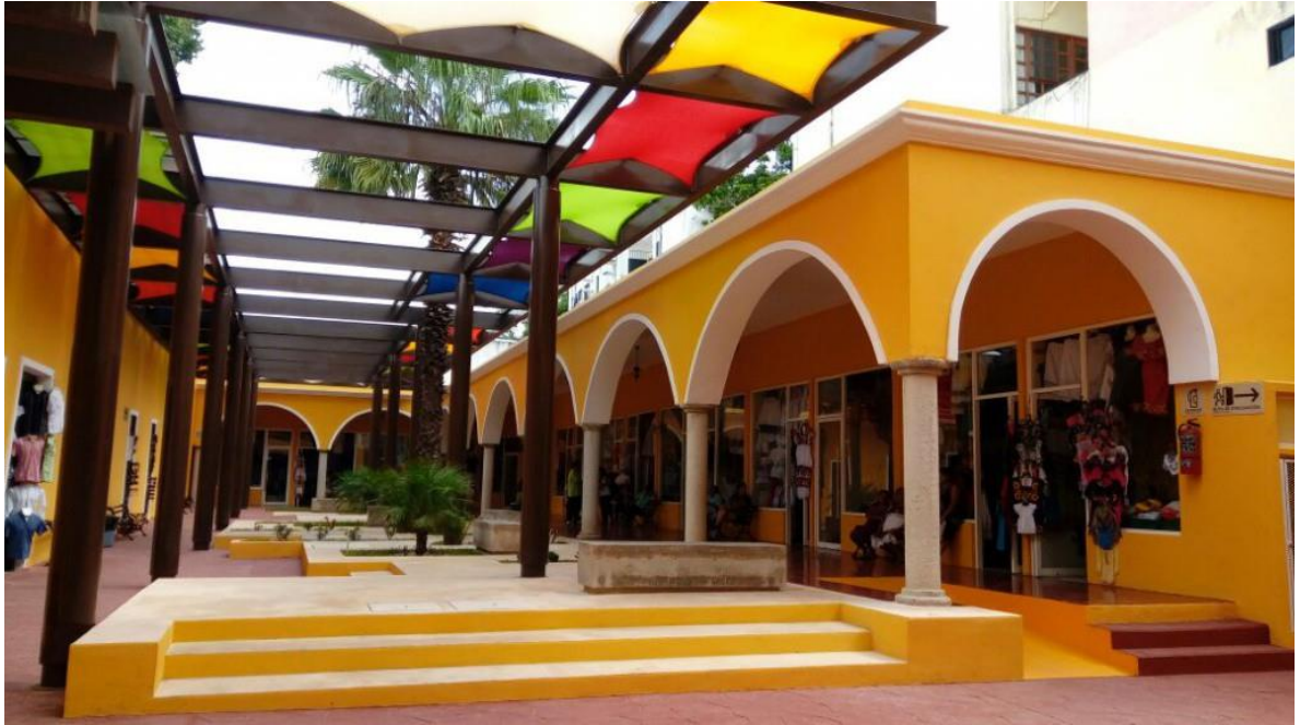
1 Centro Artesanal Zací , sitio en calle 39 entre calle 30 y 32 en Colonia Centro, Valladolid, Yucatán.
