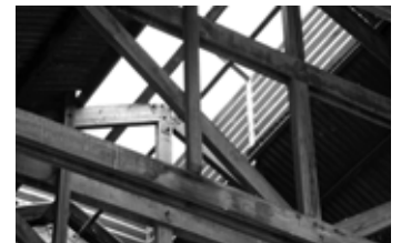
Toma de muestras en cerchas, marcos de puertas y ventanas, arriostres para saber el tipo de madera con que se fabricaron.
