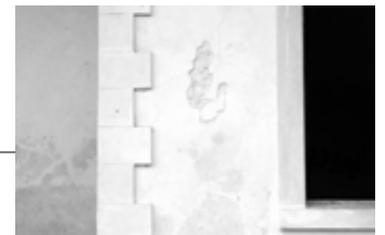
Catas sobre jambas de ventanas para saber el cromatismo de la antigua estación
