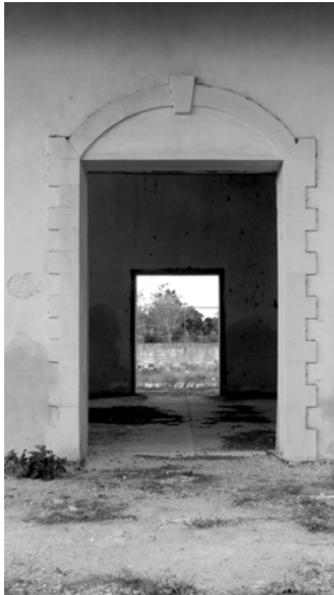
Figura 48_ Detalla decorativo a modo de Jamba dentada. Vanos de acceso a la antigua bodega Fuente: Autor
