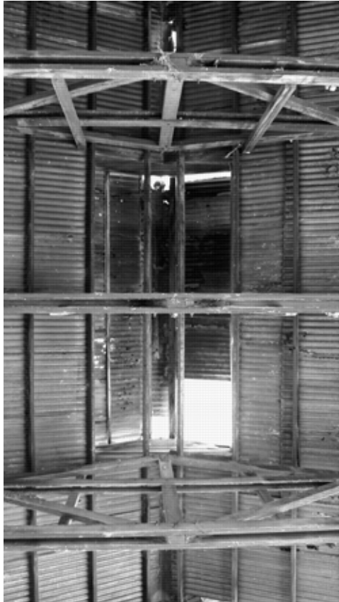
Figura 50_ Cubierta. Detalle de la montera y cerchas Fuente: Autor
