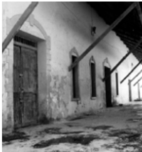
Depósito de piezas empresa Tyasa
