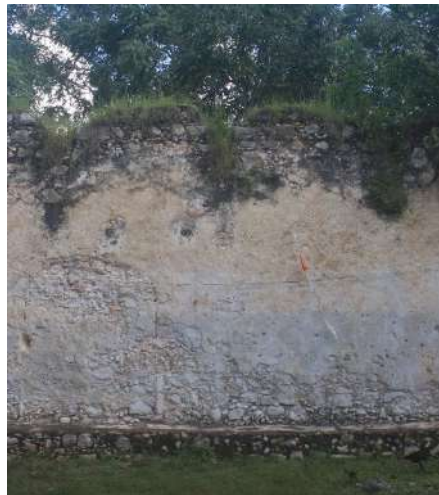
Foto 102. Huecos en muro donde descansan vigas de madera. Foto: Cortesía, Luis Ojeda Godoy, 2014
