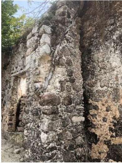
Foto 59. Contrafuerte norte, claramente adosado a muro de nave. Foto: LAR, enero 2018
