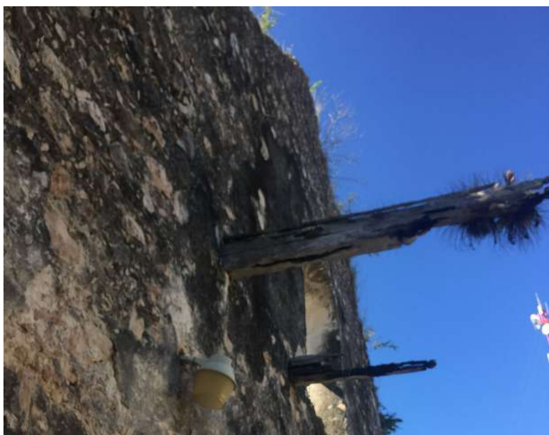
Foto 75. Vestigios de vigas de madera en área de coro. Foto: LAR, noviembre 2017
