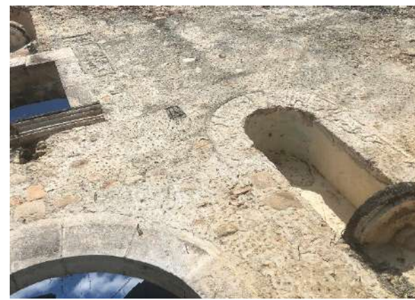
Foto 113. Acabado rajueado en cuerpo central de fachada principal. Foto: LAR, abril 2018
