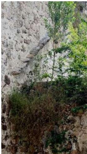
Foto 12. Chaflán en muro que indica la presencia de cubierta a dos aguas. Foto. LAR, enero 2018
