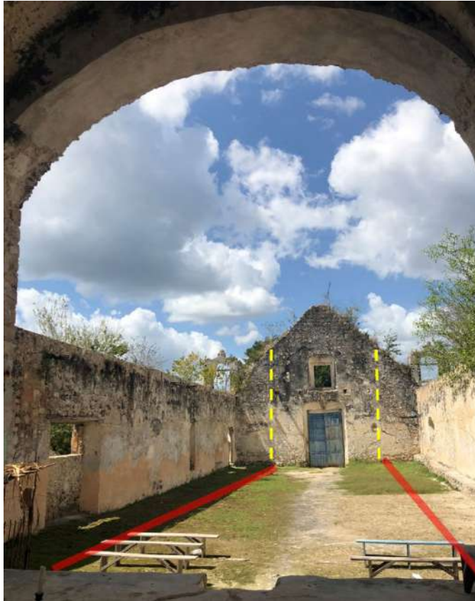
Foto 125. Posible ubicación de muros en una primera etapa. Foto: LAR, febrero 2018.
