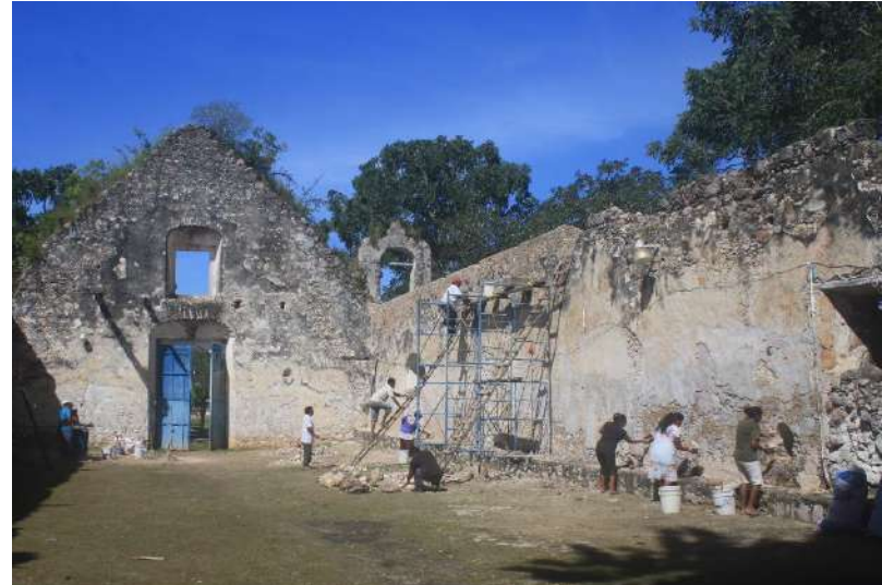
Foto 62. Habitantes de Sacalaca participando en la consolidación de muros de la nave en el año 2014. Foto: Cortesía Arq. Luis Ojeda, INAH Q. Roo, 2014
