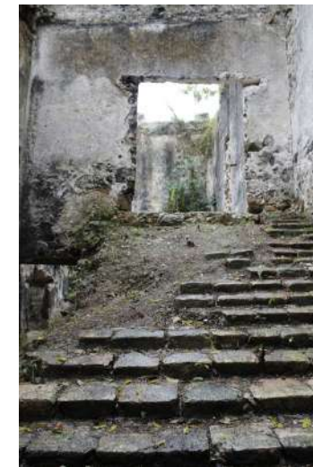
Foto 77. Escalinata de acceso a planta alta de camarín. Foto: LAR, noviembre 2017
