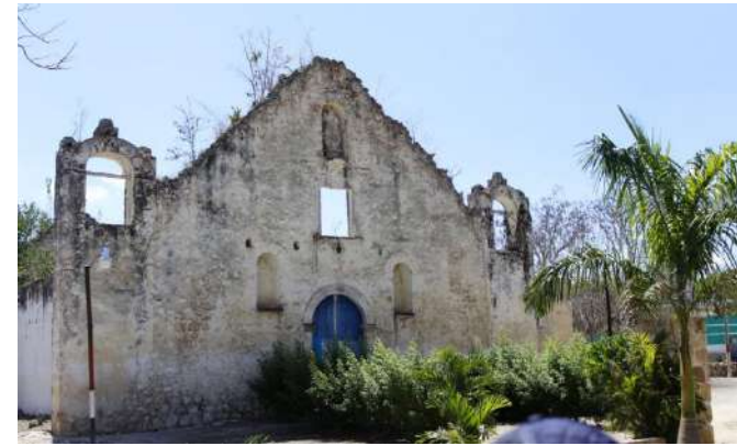
Foto 2. Fachada principal de la Capilla de la Asunción. Foto: EJGV, abril 2018
