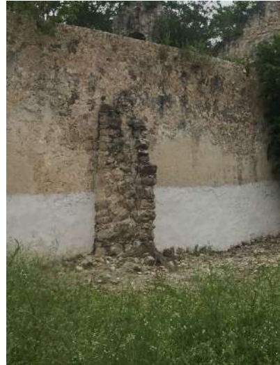
Foto 60. Contrafuerte sur, adosado a muro de nave. Foto: LAR, junio 2017
