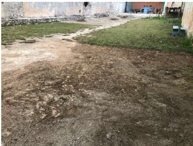
Foto 110. Estado actual del piso en nave. Foto: LAR, marzo 2018
