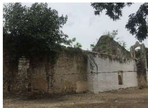
Foto 9. Contrafuertes en muro norte de nave. Foto: EJGV, noviembre 2017
