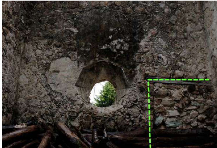
Foto 585. Vano tapiado que conectaba el bautisterio con la nave. Foto: LAR, noviembre, 2017.
