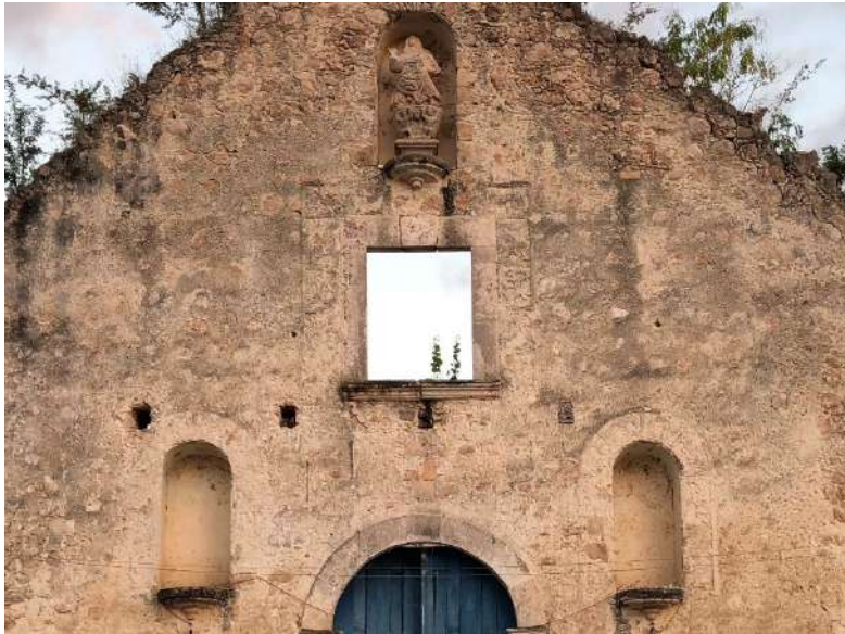
Foto 81. Detalle de relieve con elementos florales en marcos de nichos y ventana coral, así como imagen de Virgen en fachada principal. Foto: LAR, noviembre 2017
