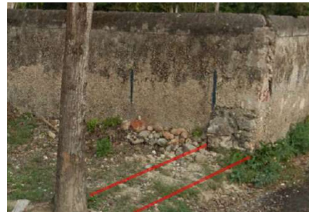
Foto 27. Posible presencia de muro. Foto: LAR, noviembre 2017
