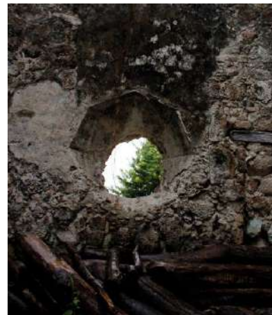
Foto 16. Ventana en muro poniente de bautisterio. Foto: EJGV, noviembre 2017
