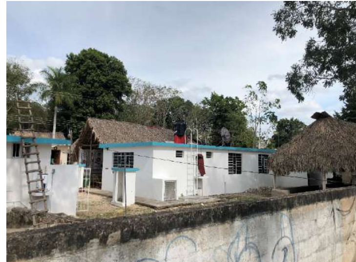
Foto 65. Centro de Salud localizado en la colindancia norte, vista desde la Capilla. Foto: LAR, enero 2018
