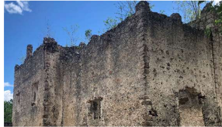
Foto 84. Remate de muros en pináculos. Foto: LAR, mayo 2018
