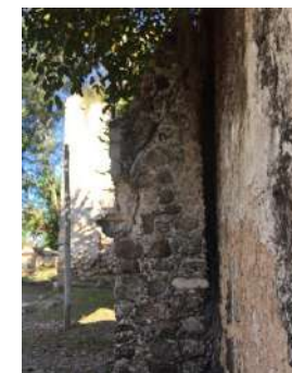
Foto 10. Contrafuerte con aparejo de mampostería ordinaria. Foto: LAR, enero 2018
