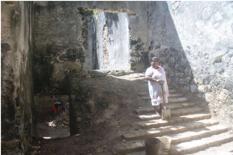
Foto 61. Realización de trabajos de limpieza en área de camerín por parte de los pobladores. Foto: Cortesía Arq. Luis Ojeda, INAH Q. Roo, 2014
