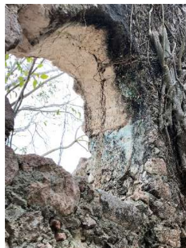
Foto 117. Restos de pintura en intradós de ventana de bautisterio. Foto: EJGV, noviembre 2017
