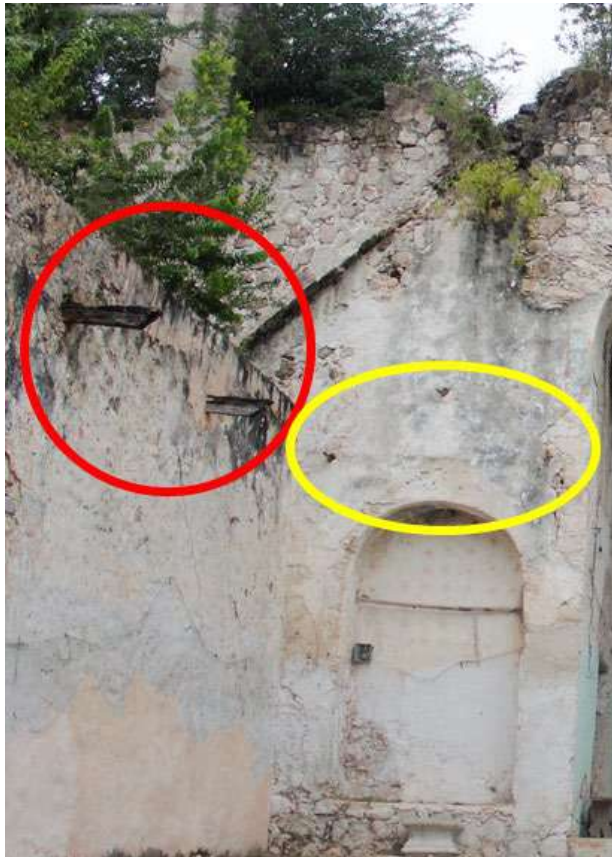
Foto 120. Indicadas en rojo, vigas de madera colocadas en muro, en amarillo, pedazos de madera incrustados sobre nicho alineados a la pintura mural existente. Foto: Leslie Adame. Noviembre 2017.
