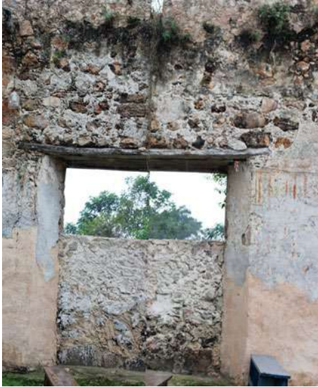
Foto 87. Pintura mural, donde se observa frontón y columna estriada. Foto: EJGV, noviembre 2017
