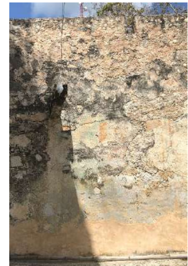
Foto 91. Pintura mural en área de nave, bajo vigas de madera. Foto: LAR, febrero 2018.
