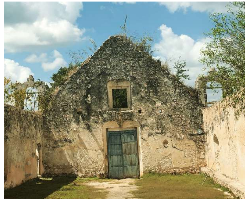
Foto 131. Vista interior de muro de fachada principal. Foto: LAR
