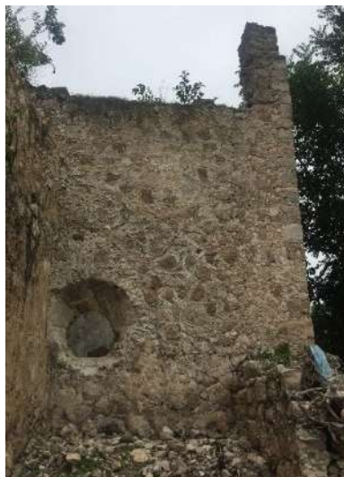
Foto 7. Muro con aparejo de mampostería ordinaria. Foto: LAR, julio 2017
