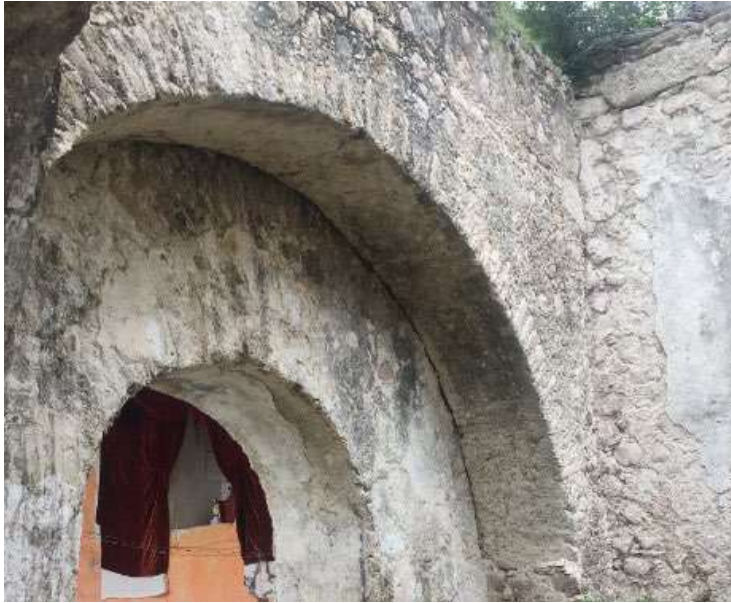
Foto 13. Arco elaborado con aparejo de piedra fza en muro de bautisterio en colindancia con presbiterio. Foto: LAR, noviembre 2017
