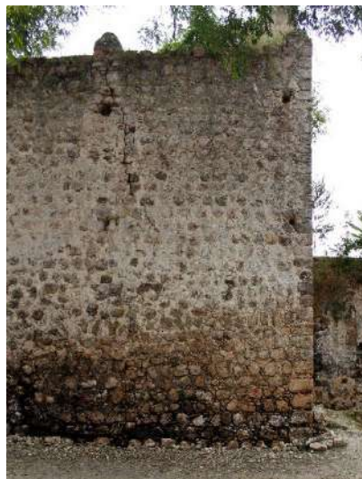
Foto 8. Muro con aparejo de hilada. Foto: LAR, julio 2017
