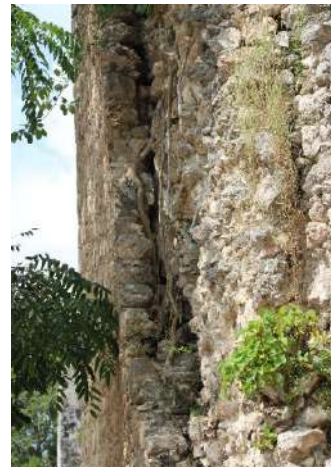
Foto 5. Doble hoja y núcleo en muro. Foto: EJGV, noviembre 2017
