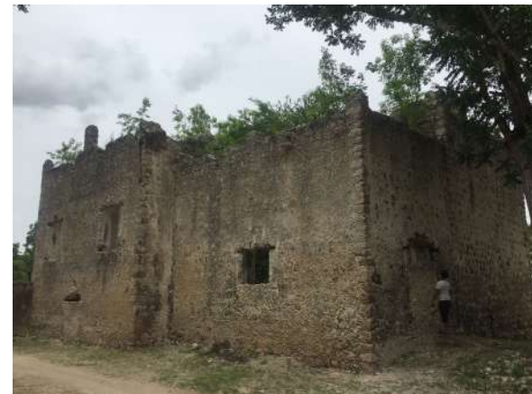
Foto 95. Fachada posterior con refuerzo de sillar en esquina. Foto: LAR, julio 2017
