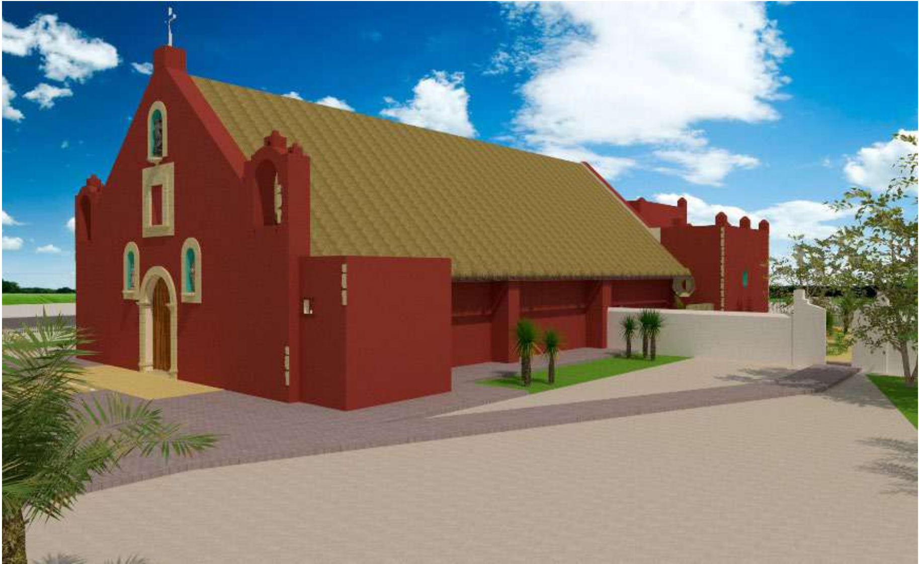
Figura 65. Fachada sur. Elaboración propia
