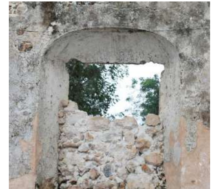
Foto 107. Arco escarzano con capialzado de Marsella en vano de nave principal. Foto: EJGV, noviembre, 2017
