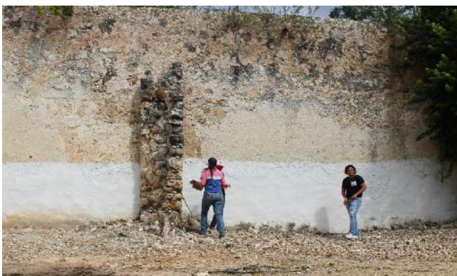
Foto 7210. Realización de levantamiento con cinta y láser. Foto: EJGV, noviembre
