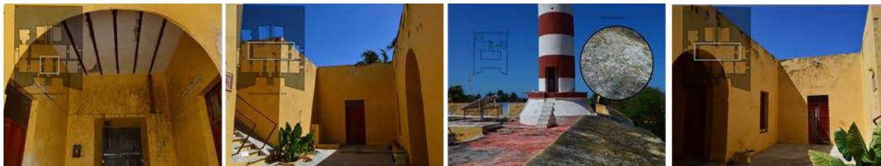
Ilustración 33 Fuerte de Sisal. Patio Interior. Fotografía. Karla Gómez 2017
