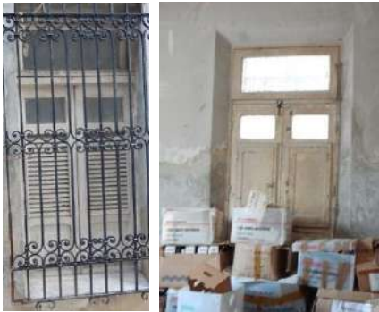
ILUSTRACIÓN 10 VENTANA 3 EXTERIOR E INTERIOR
