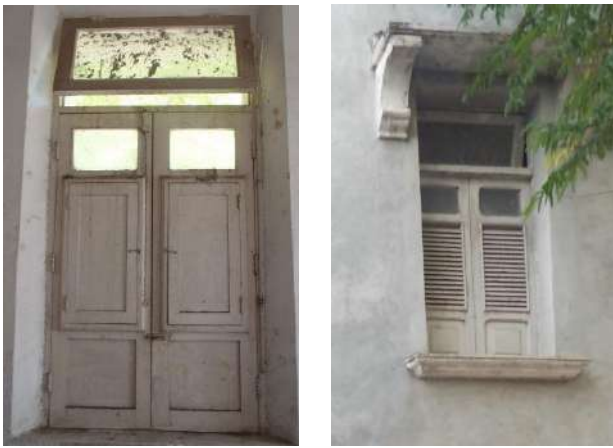
Ilustración 60 Ventana 19 Exterior e interior
