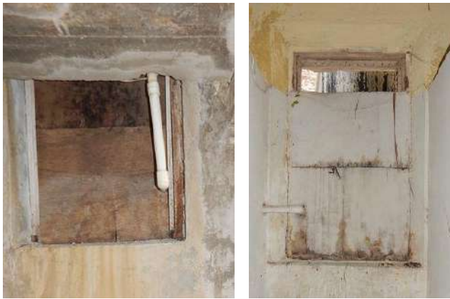
ILUSTRACIÓN 12 VENTANA 5 EXTERIOR E INTERIOR
