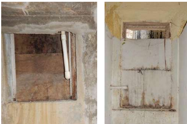
Ilustración 49 Ventana 5 Exterior e interior
