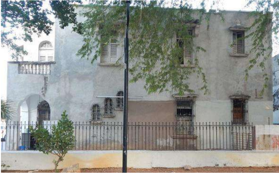
Ilustración 41 Fachada Oeste casa 1
