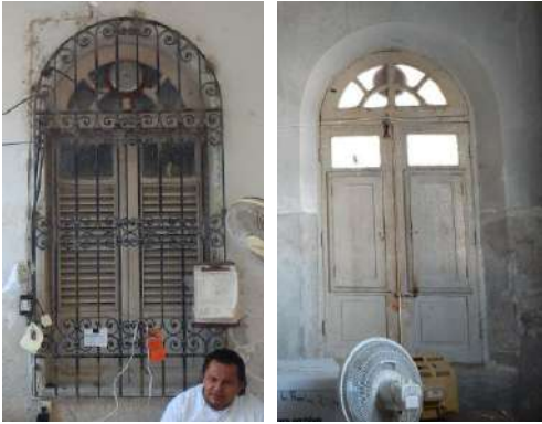
ILUSTRACIÓN 9 VENT 1 EXTERIOR E INTERIOR
