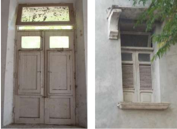
ILUSTRACIÓN 23 VENTANA 19 EXTERIOR E INTERIOR
