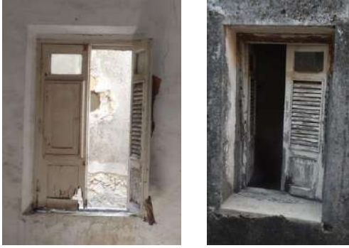
Ventana 13 Interior y exterior
