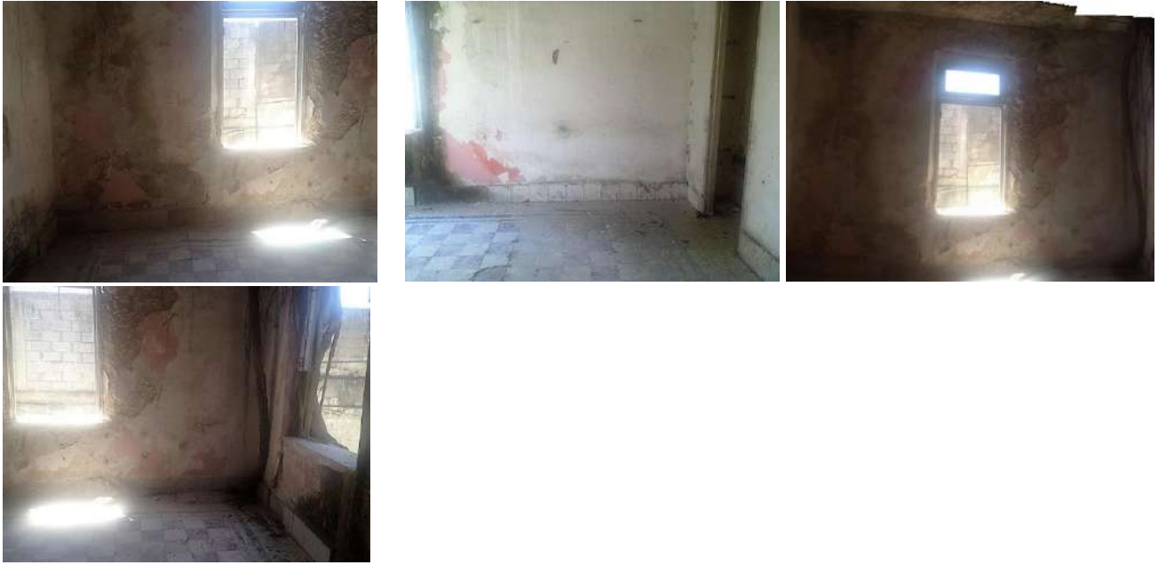
Ilustración 69 Fotos interior recamara Sur casa 2
