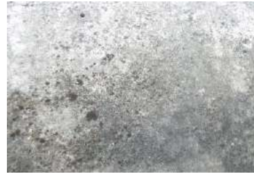
detalle de acabado
