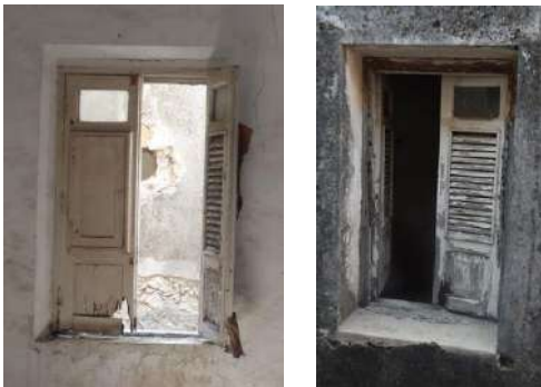
VENTANA 13 INTERIOR Y EXTERIOR
