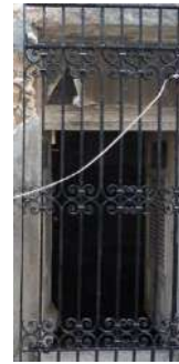
VENTANA 4 INTERIOR Y EXTERIOR
