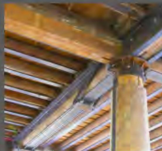
Figura 10.10. Ejemplo de un sistema de refuerzo mecánico para vigas y columnas de madera de un edificio histórico. (Fuente: Weaver, 1997.)
