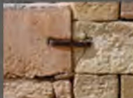
Fig. 1. Grapa metálica en un muro de piedra.
