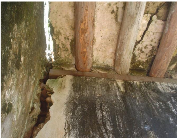
Fotos 53 y 54. Microorganismos en muros, plafones y rollizos.
