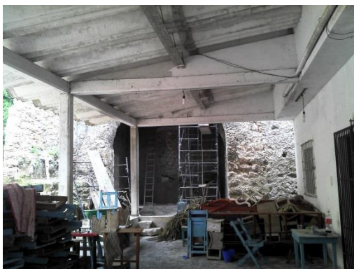
Foto 18. Anexos construidos al interior de la nave original
