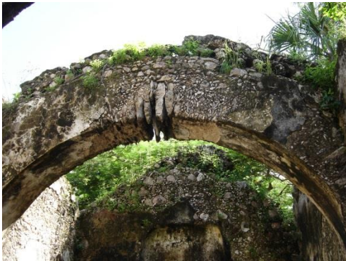
Foto 34. Fotografía del año 2005, se puede identificar el vestigio de la bóveda y los mechinales de los rollizos
