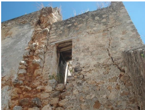
Foto 29. Presbiterio y camarín. Muros de mampostería y kancab
