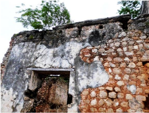
Foto 36. Vestigio de la losa de bahpec y los mechinales de las vigas y canes de madera
