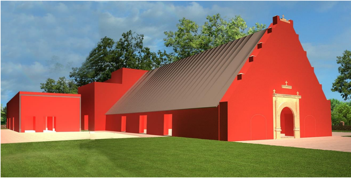
Perspectiva 4. Vista del conjunto, con otra propuesta de color, se observa la reconstrucción de cubierta y anexos.
