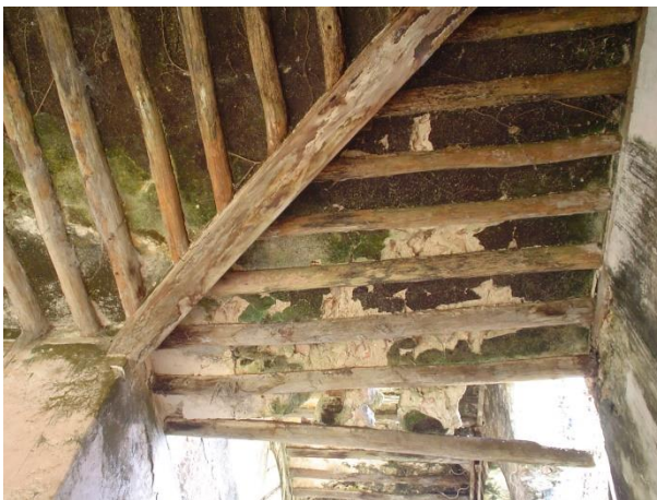
Foto 27. Rollizos de madera en losas de bahpec
