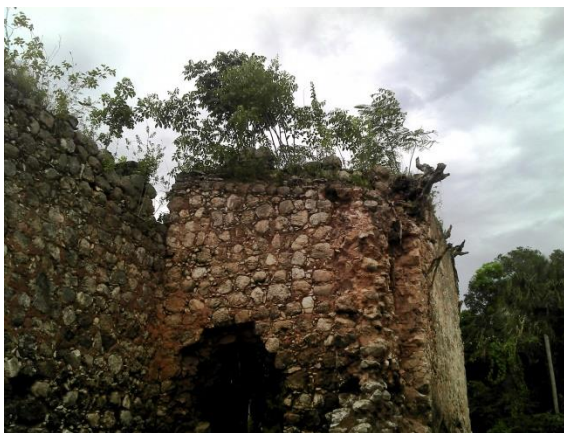
Foto 26. Morteros a en muros de mampostería a base de k'ancab
