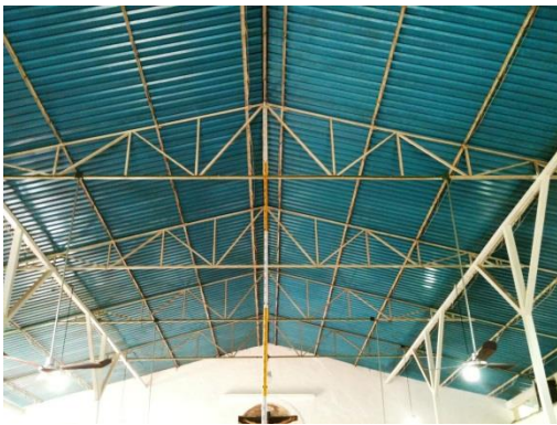
Foto 31. Cubierta metálica en la nave actual del templo.
