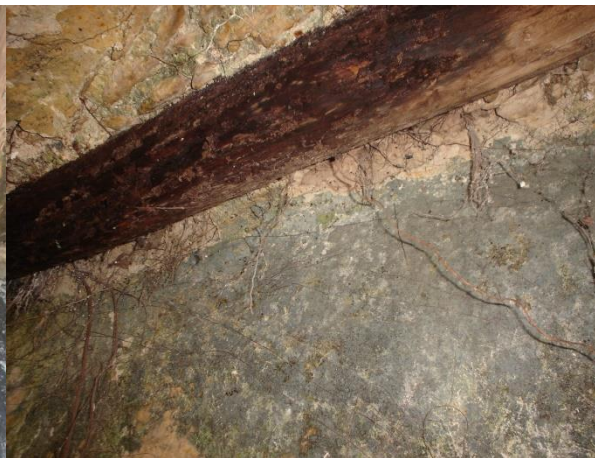
Fotos 53 y 54. Microorganismos en muros, plafones y rollizos.
