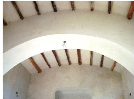
Foto 35. Cubierta actual, de losa de vigueta y bovedilla sobre rollizos de madera
