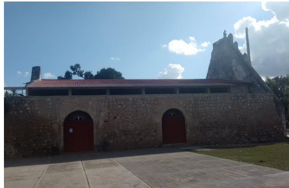
Foto 7. Fachada norte, templo
