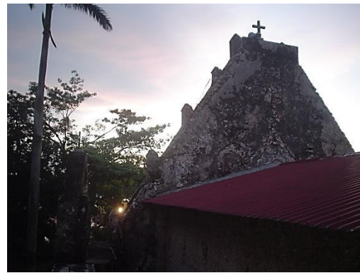
Foto 32. Vestigio en la parte posterior de la fachada de la cubierta original a dos aguas
