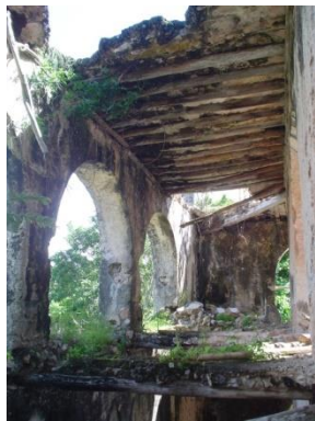
Foto 38. Sistema de losa de bahpec sobre rollizos de madera.
