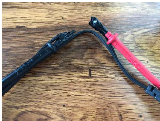
Figura. 11 Colocación de cinta aislante
