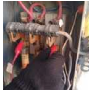
Figura 4. Colocación de Caimanes para obtener voltaje
