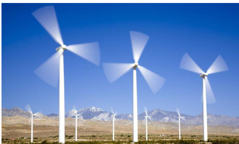
Figura 2.1.2: Aprovechamiento de energía eólica mediante aerogeneradores.
