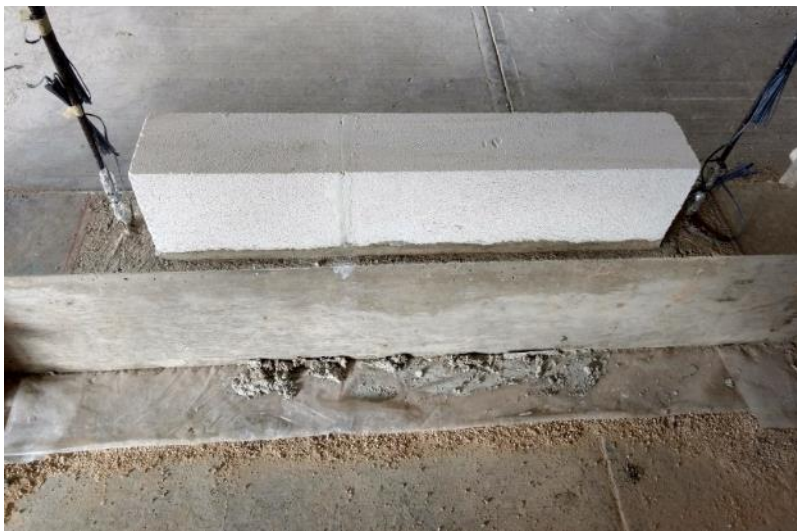
Figura 3.12 Primera hilada de bloques de CCA
