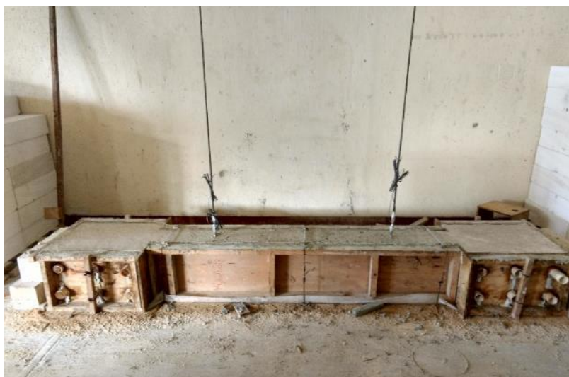
Figura 3.10 Base del muro
