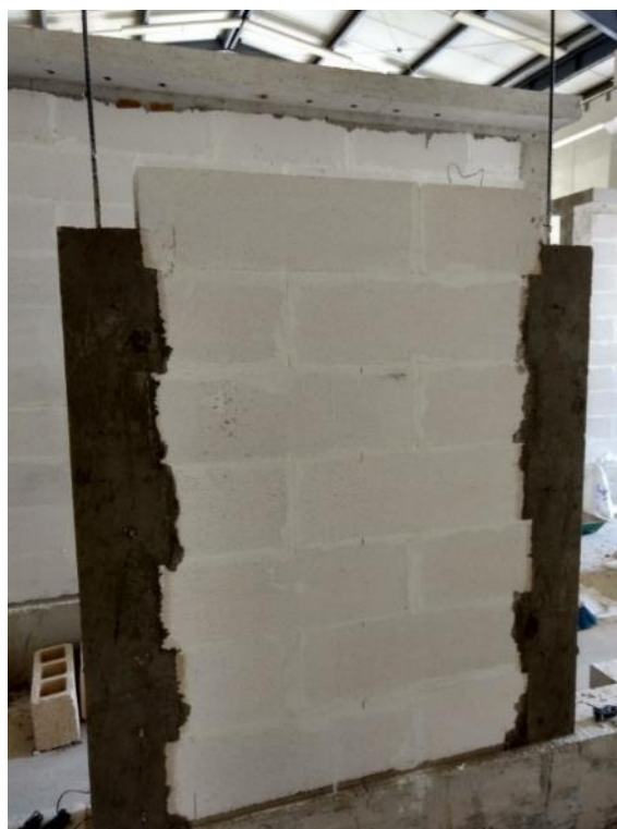
Figura 3.13 Muro construido hasta la mitad de su altura
