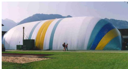
Figura 2.10. Cubierta de cancha de tenis (estructura permanente).
