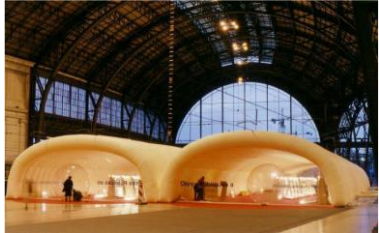
Figura 2.9. Edificio "Buildair", Barcelona (baja presión, estructura temporal).
