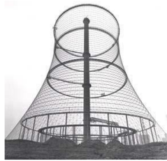
Figura 2.7. Torre de refrigeración, Schmiehausen (permanente).
