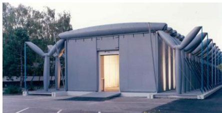
Figura 2.8. Edificio Festo, Stuttgart (alta presión, estructura permanente).
