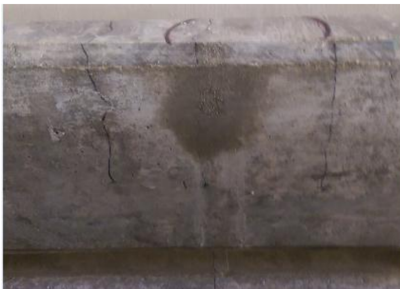
Figura 3.29 Resane de trabe perforada con mortero 1:3
