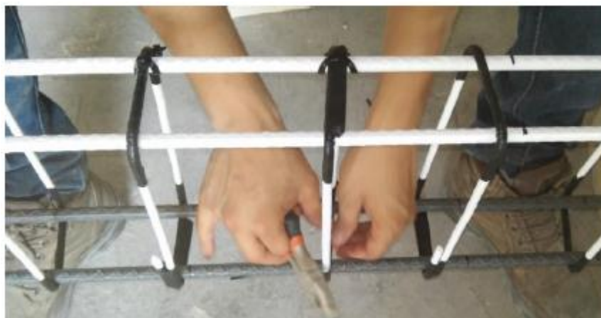
Figura 3.8 Aislamiento de AR longitudinal del transversal
