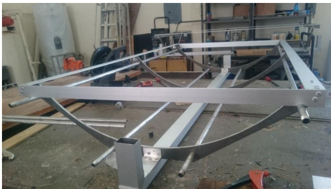
Figura 25. Construcción de un colector de canal parabólico, sin la superficie reflectante.
