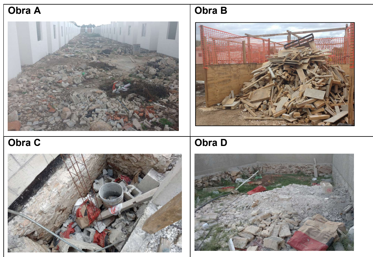
Figura 6. Forma en el que se encuentran almacenado los RCD en las diferentes obras. Fuente: Elaboración propia.
