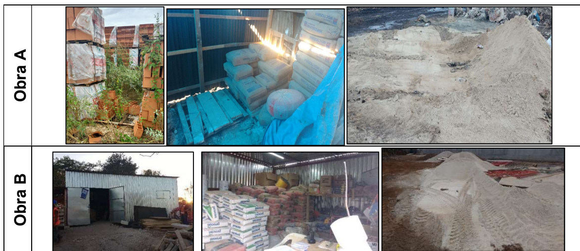
Figura 5. Condiciones de almacenamiento de los materiales interior y exteriormente. Fuente: Elaboración propia.
