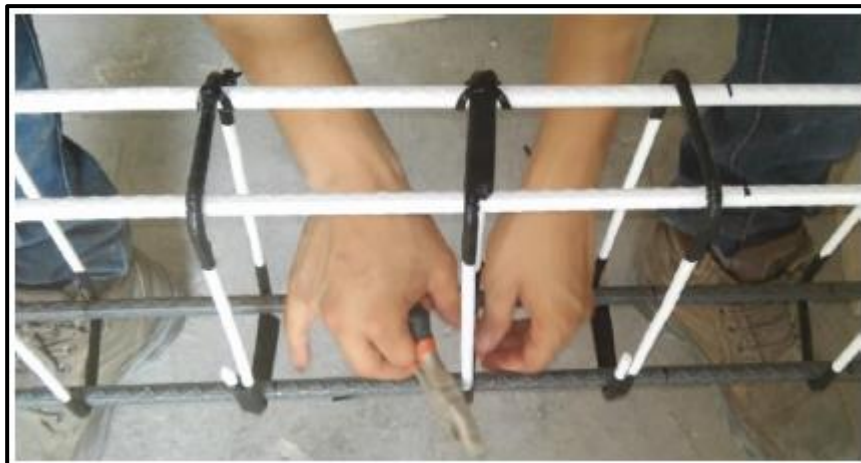
Figura 2.5 Aislamiento de AR longitudinal del transversal
