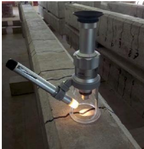
Figura 4.9 Medición del ancho de grietas en trabes de CR con microscopio
