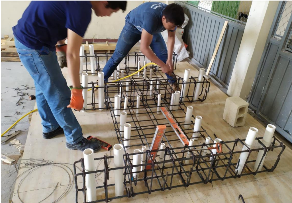
Figura 3.12 Colocación de tubos de PVC.
