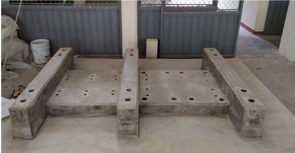
Figura 3.15 Deshabilitado de cimbra.
