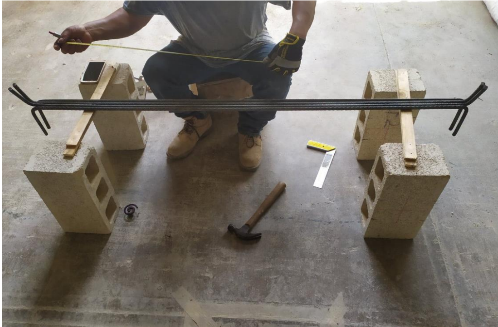
Figura 3.11 Habilitado del acero de refuerzo.
