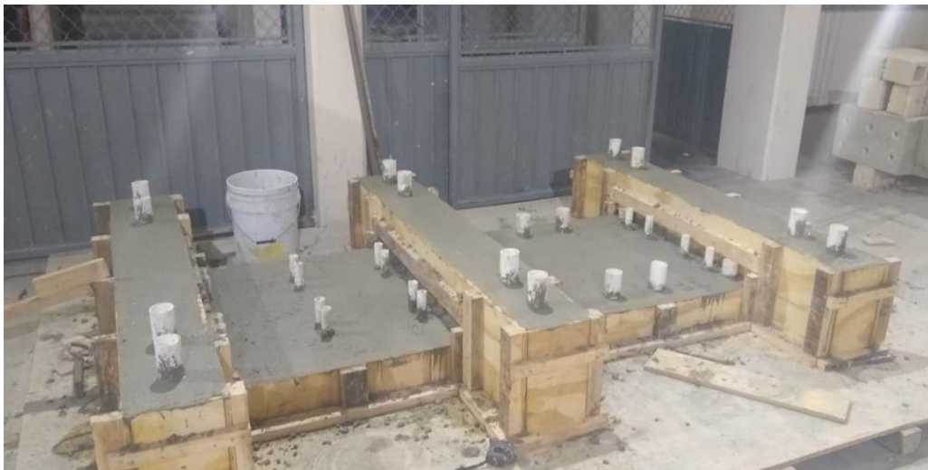
Figura 3.14 Colocación del concreto.
