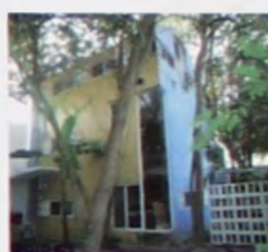
La primera es un muro de block (H=2.20 m) pre-existente que delimita el terreno, el cual es trabajado mediante, un juego de adiciones y sustracciones a diferentes alturas que responden a actividades específicas: entrada peatonal y vehicular, vegetación existente con expresividad hacia la calle, acometidas eléctricas e hidráulicas. Este muro remata con franjas de herrería (elemento transparente). Es de acabado estucado y está pintado en color blanco.
