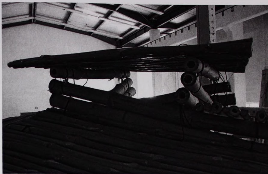
Imagen 3.60 Cumbra terminada. Fotografía: Carlos Uribe
