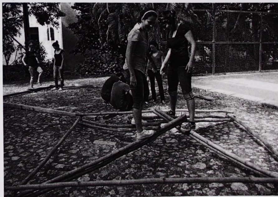
Imagen 3.76 Marco de madera y estructura de la techumbre
