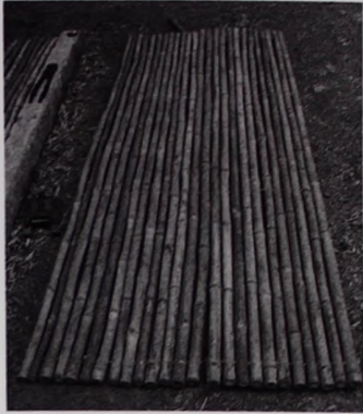
Imagen 2.16 Elaboración de paneles de bambú en la Hacienda Xixim, Yuc.
