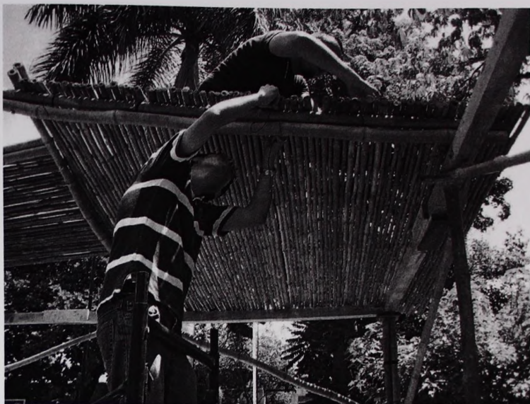
Imagen 3.81 Montaje y sujeción de los paneles. Fotografía: Gabriel del Castillo C.
