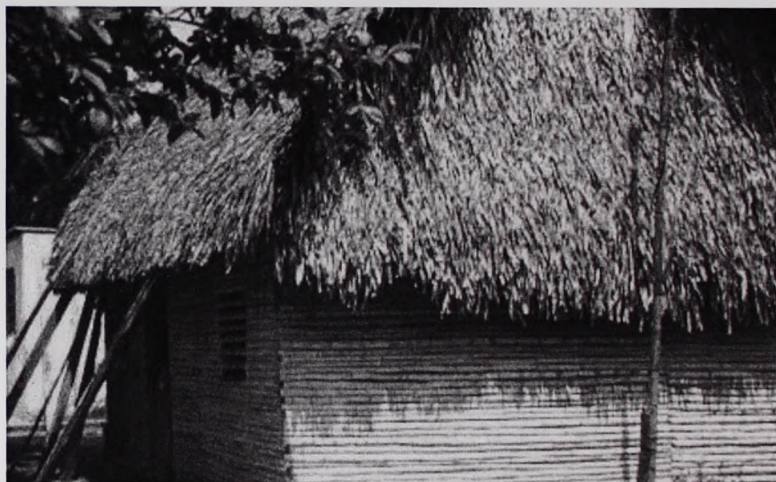
Imagen 1.11 Vivienda de bambú. México
