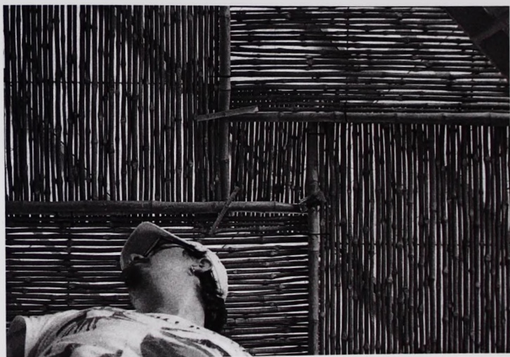
Imagen 3.63 Aspecto final de la techumbre (interior). Fotografía: Carlos Uribe
