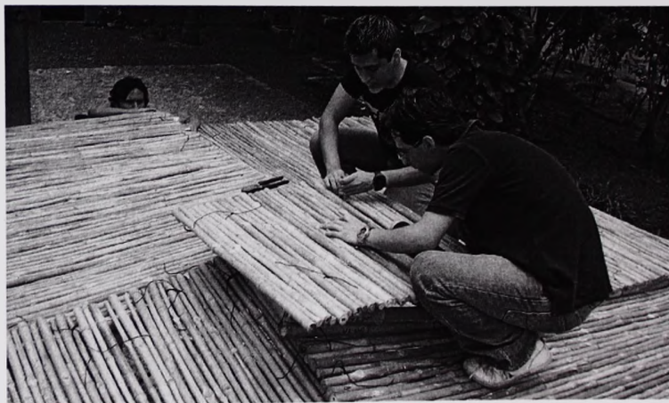
Imagen 3.82 Colocación de la cumbrera. Fotografía: Carlos Uribe.
