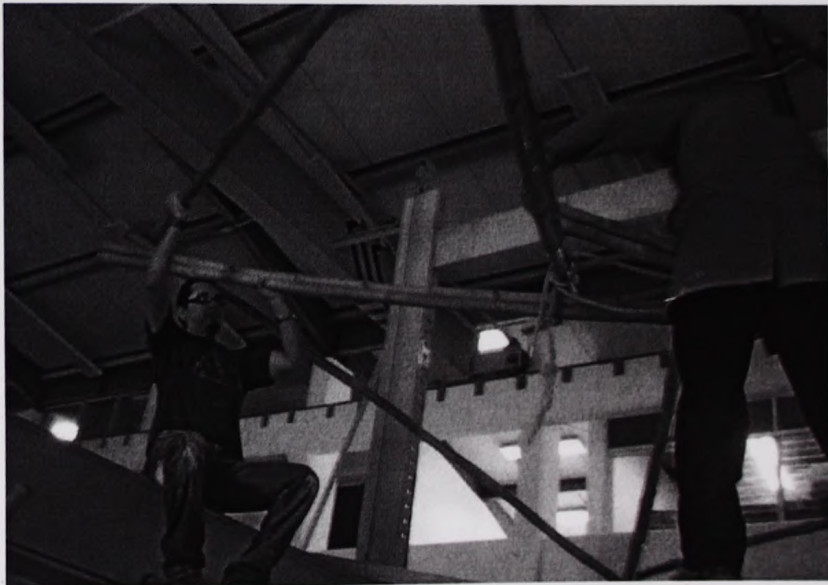
Imagen 3.45 Elevación y colocación de la estructura Fotografía: Carlos Uribe
