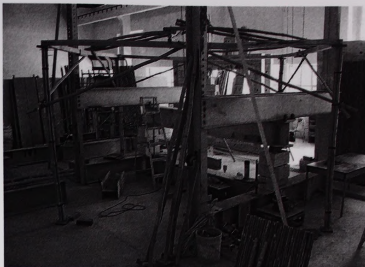
Imagen 3.69 Estructura auxiliar de soporte. Fotografía: Carlos Uribe
