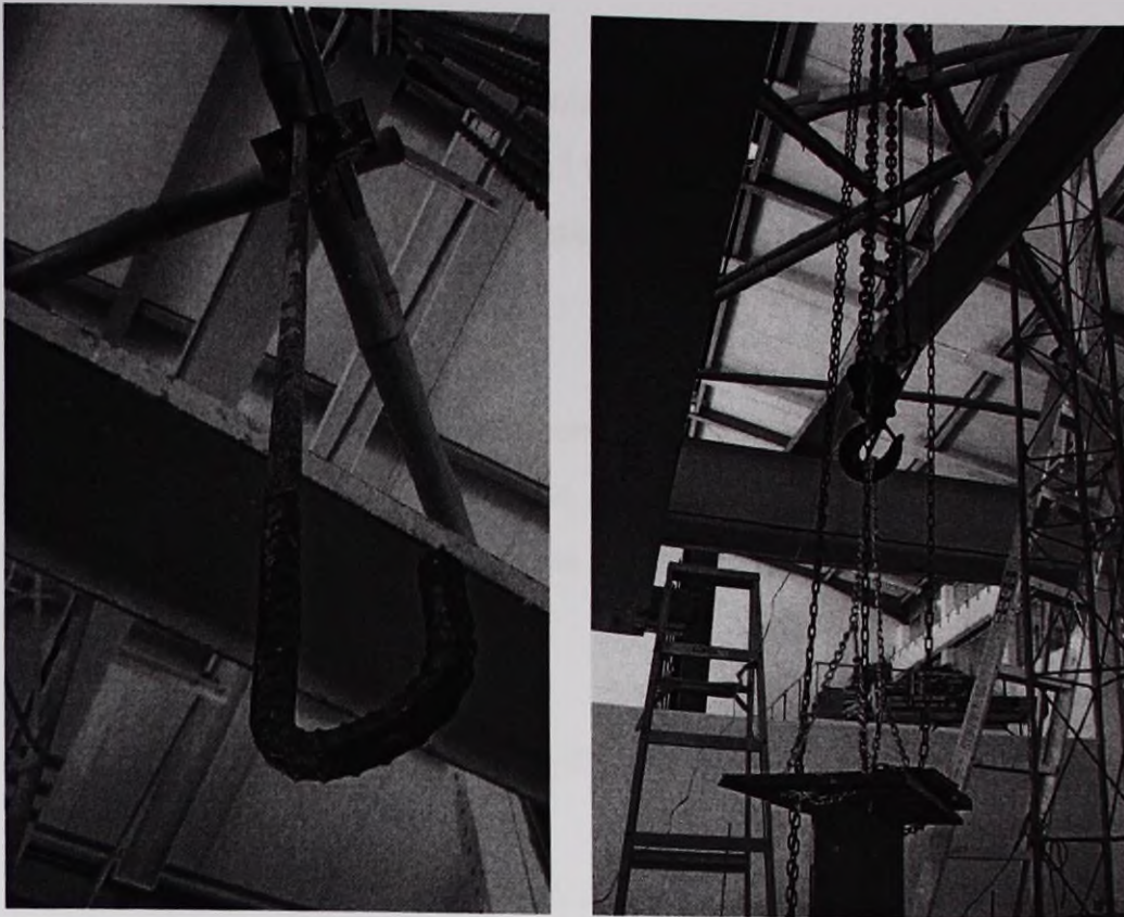
Imagen 3.10 Carga aplicada en W2 Fotografía: Carlos Uribe
