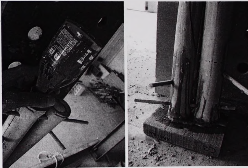
Imagen 3.67 Colado de concreto en los extremos de columnas esquineras
