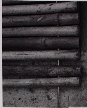
Imagen 2.16 Elaboración de paneles de bambú en la Hacienda Xixim, Yuc.
