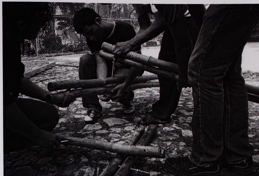
Imagen 3.75 Armado de la estructura de la techumbre
