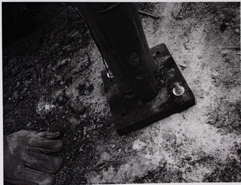
Imagen 3.79 Anclaje de las columnas esquineras al piso
