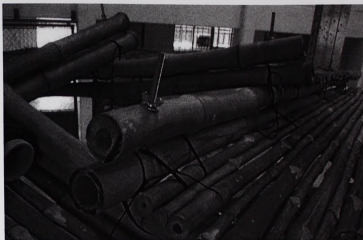
Imagen 3.53 Sujeción de los paneles a la estructura. Fotografía: Carlos Uribe
