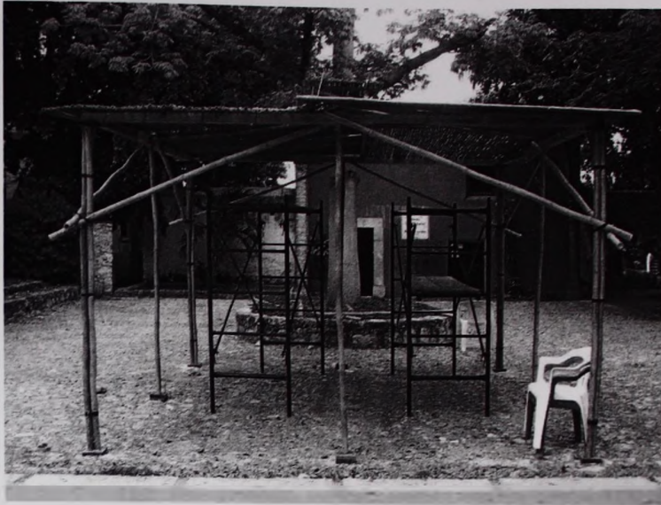
Imagen 3.83 Sistema de techumbre terminado. Fotografía: Gabriel del Castillo C.
