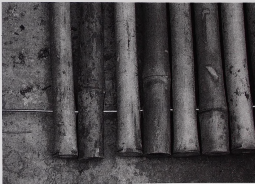
Imagen 2.6 Paneles de Bambú, hacienda Xixim Yucatán
