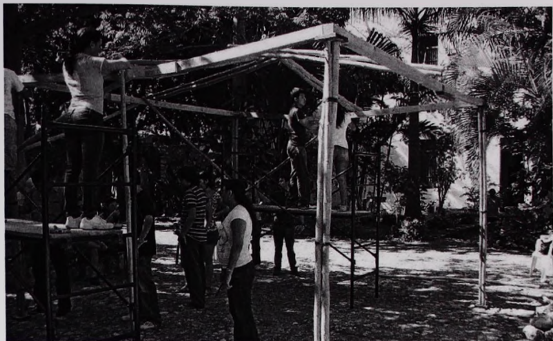
Imagen 3.78 Colocación de columnas esquineras y contravientos.
