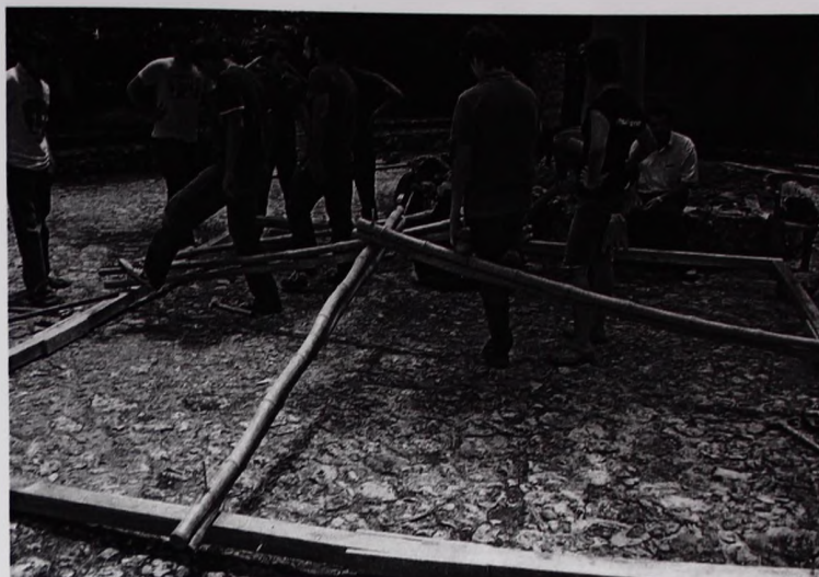
Imagen 3.77 Estructura de la techumbre sujeta al marco de madera
