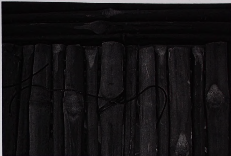
Imagen 3.54 Sujeción de los paneles a la estructura. Fotografía: Carlos Uribe
