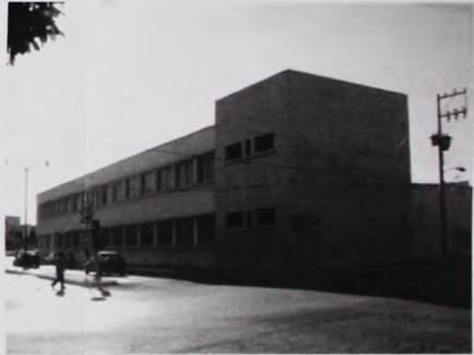
Foto No. 6. Fachada del edificio de aulas. El volumen más alto corresponde al área de servicios.
