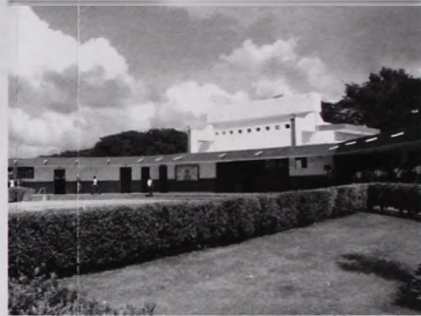
Foto No. 5. Vista hacia el vestíbulo de acceso desde una de las zonas ajardinadas contiguas a las aulas
