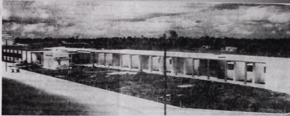
Foto No. 1. Fachada del edificio en su estado original.
