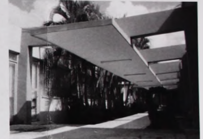
Foto No. 5. Vista del corredor techado.
