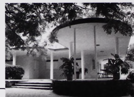
Foto No. 4. Edificio administrativo.
