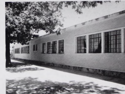
Foto No. 3. Fachada
