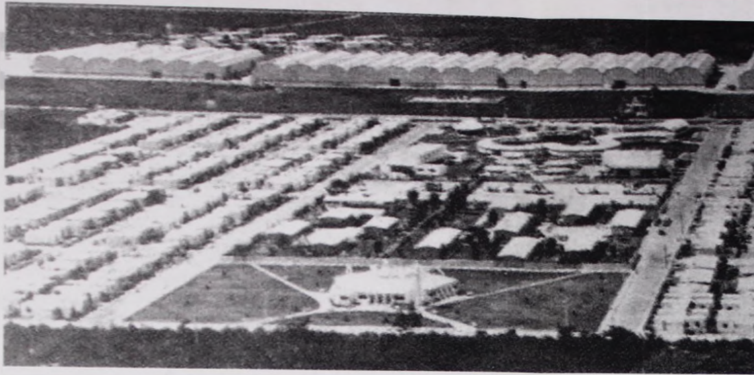
Foto No. 1. Vista del estado original de la Unidad Habitacional Revolución Cordemex. En primer plano aparece la Iglesia, tras ella se aprecia el Centro Escolar Zamná. A continuación aparecen el mercado y otros edificios de equipamiento y al fondo las naves industriales de Cordemex.
