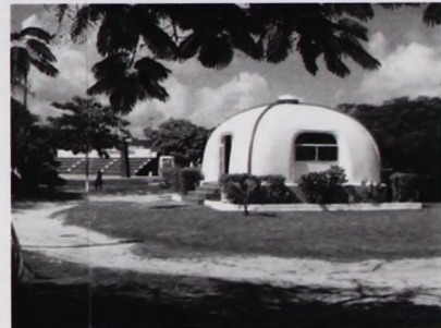
Foto No. 7. Aula prefabricada.
