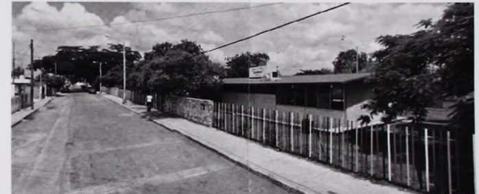
Foto No. 3. Vista de módulos de aulas desde la vialidad.
