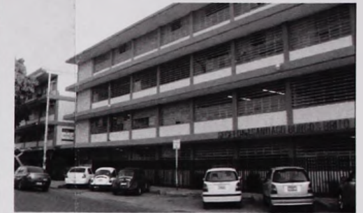
Foto No. 5. Vista de la fachada.
