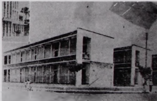
Foto No. 6. Módulos de aulas desde el interior del terreno
