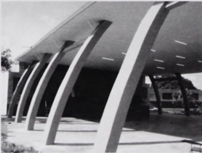
Foto No. 4. Detalle de la estructura del teatro
