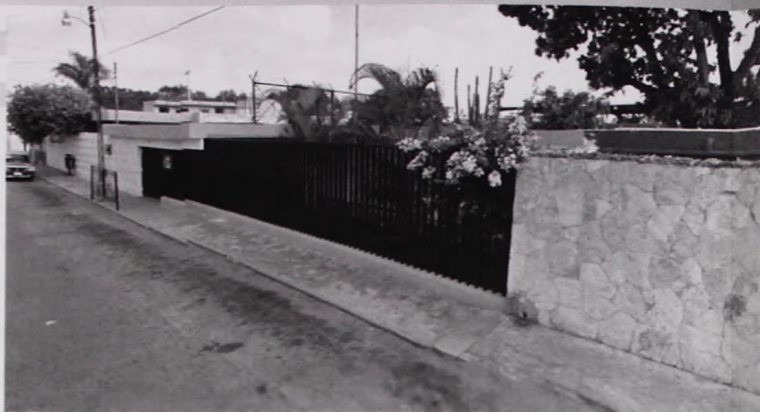
Foto No. 1. Vista de la fachada.
