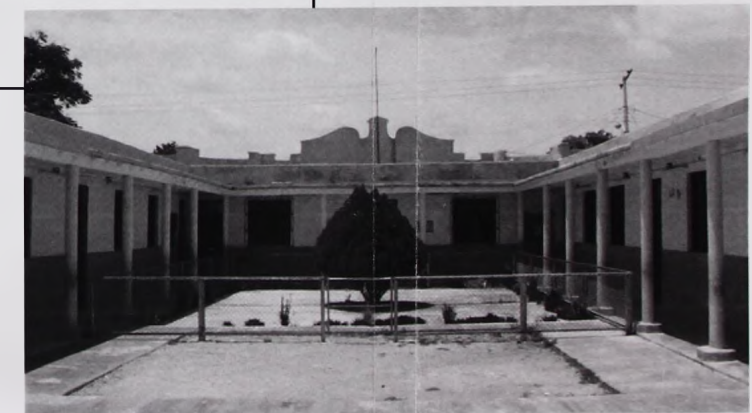
Foto No. 5. Vista del patio central
