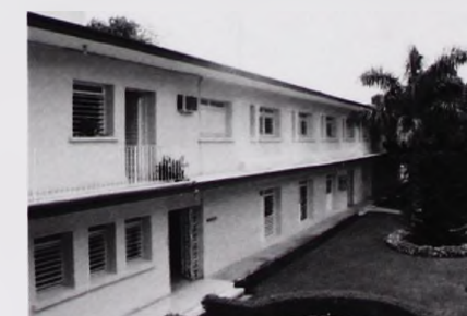
Foto No. 5. Vista del edificio de internado anexo a la antigua residencia, hoy edificio administrativo
