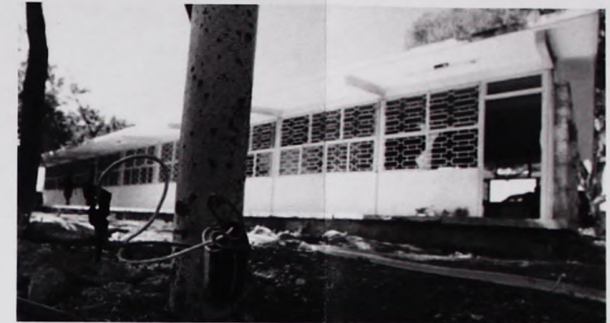
Foto No. 2. Vista de uno de los módulos de aulas.
