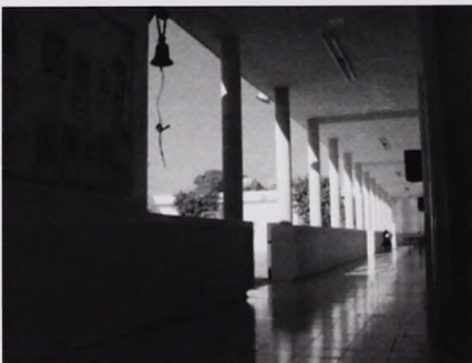
Foto No. 4. Pasillo de la planta baja del ala de aulas
