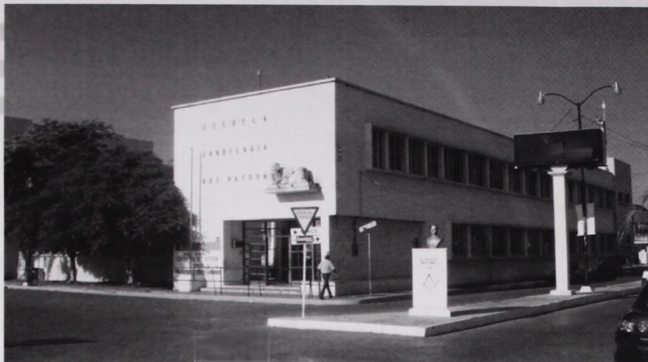
Foto No. 1. Fachada principal y fachada norte.
