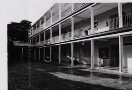
Foto No. 7. Edificio de aulas. El último nivel superior es un agregado reciente.
