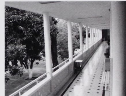
Foto No. 4. Vista del corredor del primer nivel.
