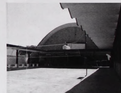
Foto No. 6. Vista del patio y el teatro
