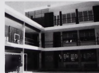
Foto No. 4. Nuevo edificio de aulas en terreno anexo.
