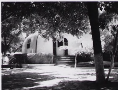
Foto No. 5. Aula prefabricada.
