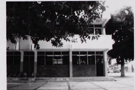
Foto No. 6. Exterior edificio de aulas.
