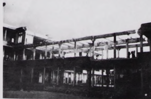
Foto No. 4: Vista del pasillo principal. Fotografía tomada durante su proceso de demolición en 1989.
