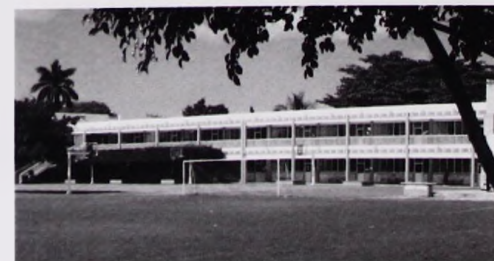
Foto No. 8. Vista actual del área de aulas del edificio.
