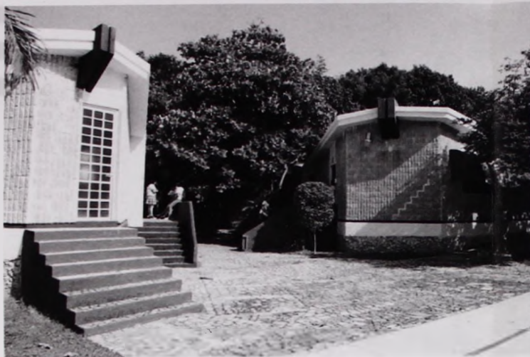
Foto No. 1. Vista exterior de módulos de aulas.
