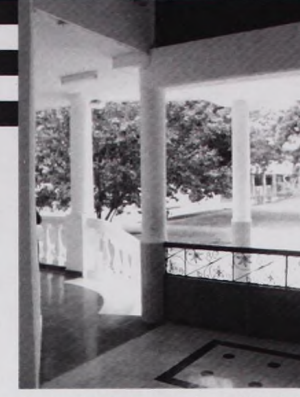
Foto No. 3. Punto de unión del corredor del edificio porfiriano con el edificio de aulas.
