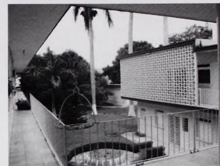
Foto No. 3. Edificio administrativo.
