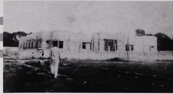
Foto No. 2. Construcción del edificio.
