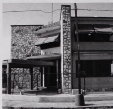
Foto No. 2. Acceso (estado actual).
