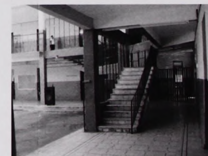
Foto No. 8. Corredor y escalera. Al fondo se ve el vestíbulo de acceso.
