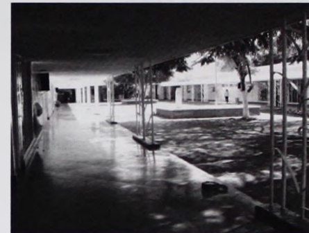
Foto No. 3. Vista del corredor de la escuela primaria.
