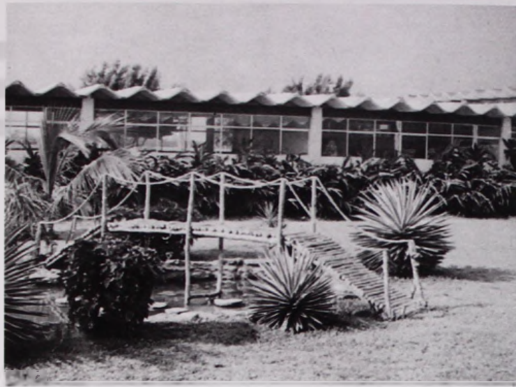
Foto No. 1. Vista del exterior de las aulas, con área ajardinada en primer plano.
