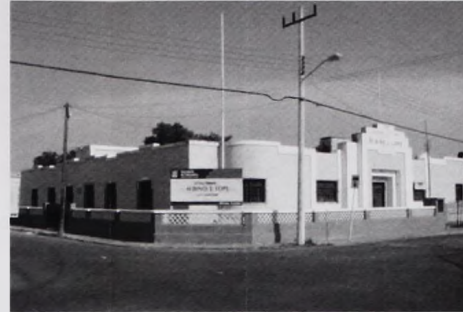
Foto No. 3. Fachada y paramento
