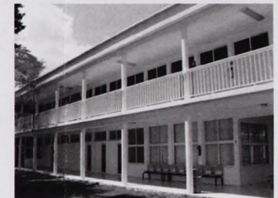
Foto No. 5. Vista de edificio de aulas
