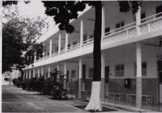
Foto No. 1. Vista del edificio de aulas desde el interior desde el interior del predio.
