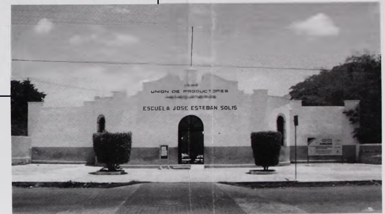
Foto No. 4. Fachada principal
