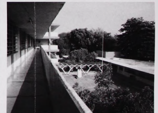
Foto No. 7. Vista hacia el patio desde uno de los pasillos del edificio de aulas.
