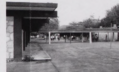
Foto No. 6. Vista de la plaza cívica y el andador techado que vincula los módulos de aulas.
