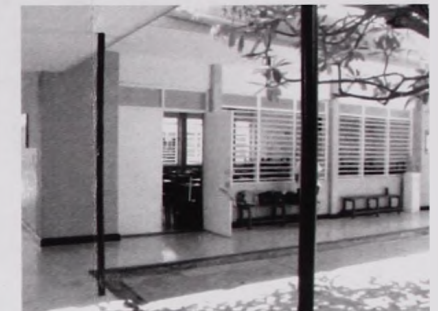
Foto No. 7. Vista exterior de un aula, desde el pasillo central
