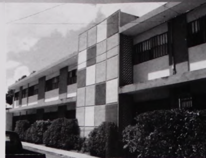
Foto No. 2. Vista de la fachada sur. El volumen que sobresale corresponde al módulo de escaleras, y cuenta con paredes laterales de celosías.
