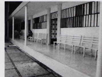
Foto No. 4. Vista del pasillo y acceso a una aula.
