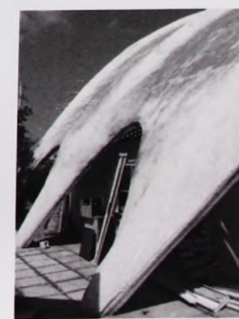
Foto No. 7. Detalle del cascarón de cubierta del teatro.
