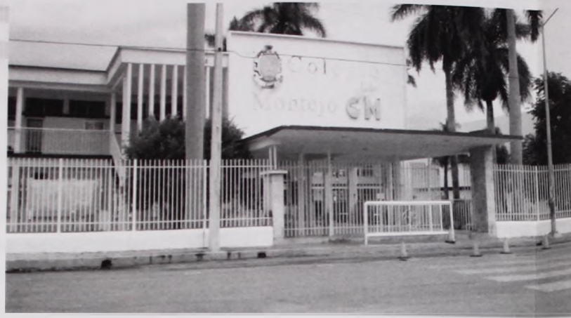
Foto No. 1. Fachada.
