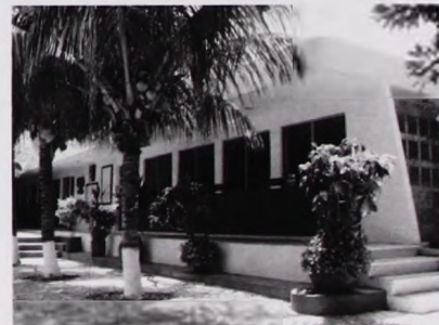
Foto No. 8. Módulo de aulas para los grados inferiores. Ha sido remodelado recientemente.
