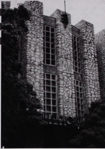
Foto No. 2. Detalle del Acceso
