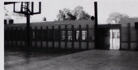
Foto No. 3. Fachada posterior de las aulas
