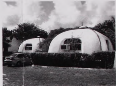
Foto No. 6. Aula prefabricada.
