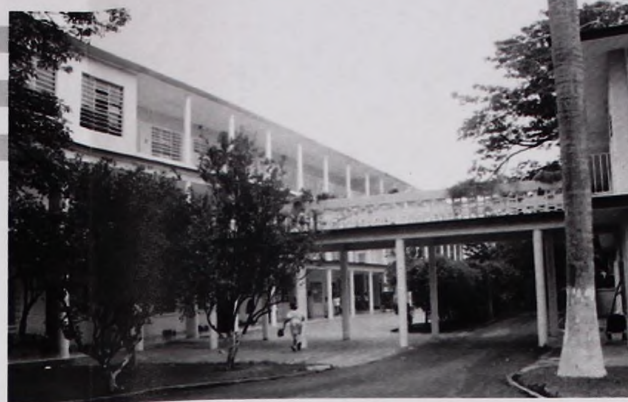
Foto No. 2. Andador-puente entre el edificio administrativo y el de aulas (en segundo plano).
