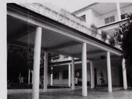
Foto No. 6. Andador-puente.
