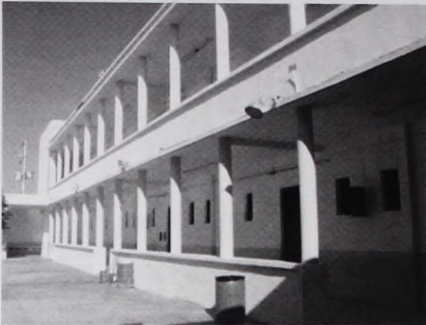
Foto No. 2. Vista de los pasillos del ala de aulas desde el patio.
