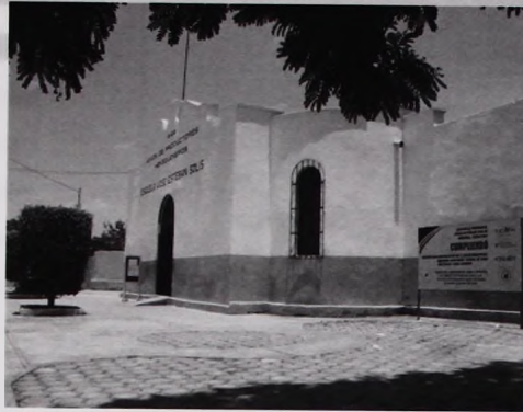
Foto No. 1. Fachada principal.
