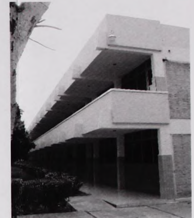
Foto No. 5. Vista hacia los pasillos de edificio de aulas.
