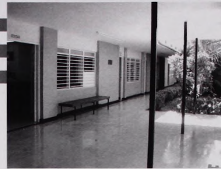
Foto No. 2. Vestibulo de acceso.
