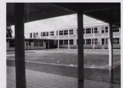
Foto No. 6. Vista del jardín desde el vestíbulo de acceso.
