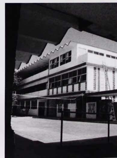
Foto No. 4. Vista del edificio de aulas
