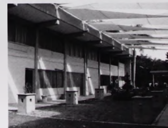
Fotos No. 2, 3 y 4. Edificios de aulas agregados en época reciente.
