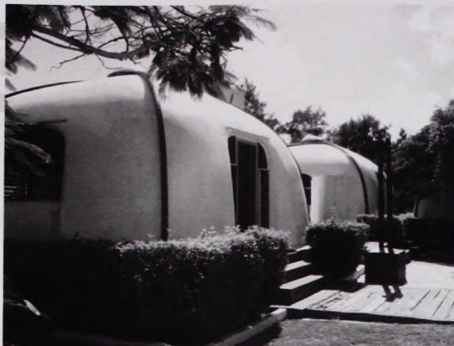
Foto No. 1. Módulos de aulas prefabricados, destinados albergar las especialidades de bachillerato
