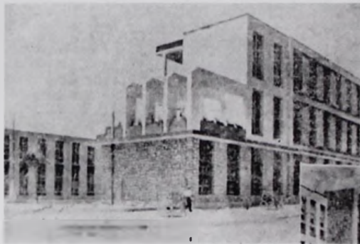
Foto No. 3: Vista parcial de la fachada y de uno de los grupos de aulas
