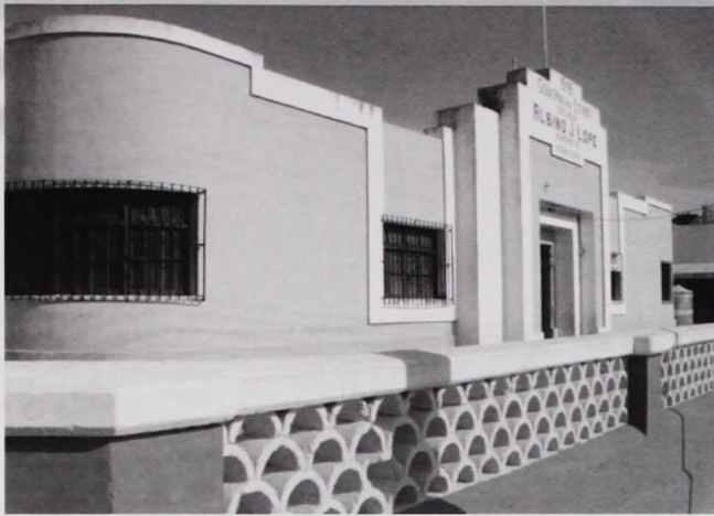
Foto No. 1. Fachada principal.
