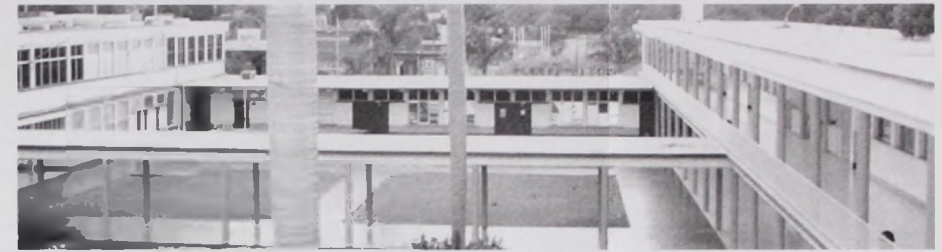
Foto No. 2. Vista del andador techado, en primer plano, con los edificios de aulas.
