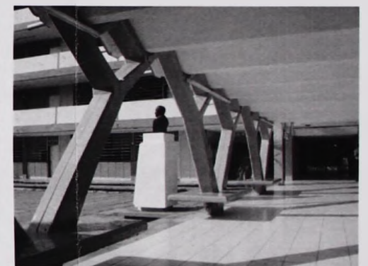
Foto No. 6. Vista del pasillo de acceso
