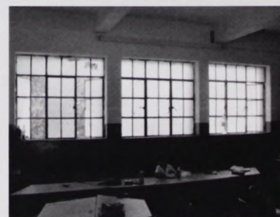
Foto No. 4, 5. Vista de las aulas.
