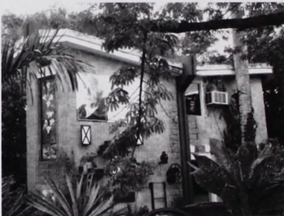
Foto No. 3. Edificio administrativo.
