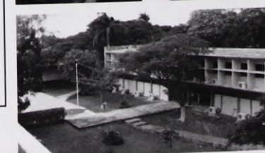
Fotos No. 4, 5. Edificios de aulas agregados en las décadas de los setentas y ochentas
