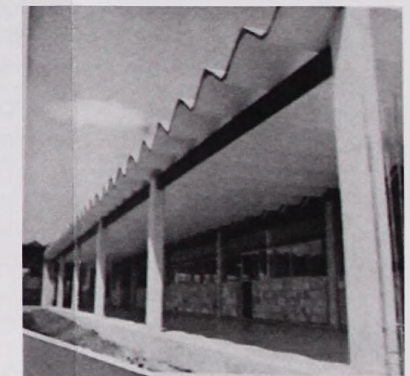
Foto No. 6. Corredor de acceso a las aulas
