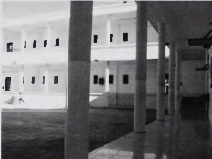
Foto No. 3. Pasillo del área de dirección.
