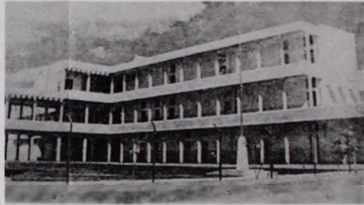
Foto No. 5. Vista del edificio principal desde el interior del terreno
