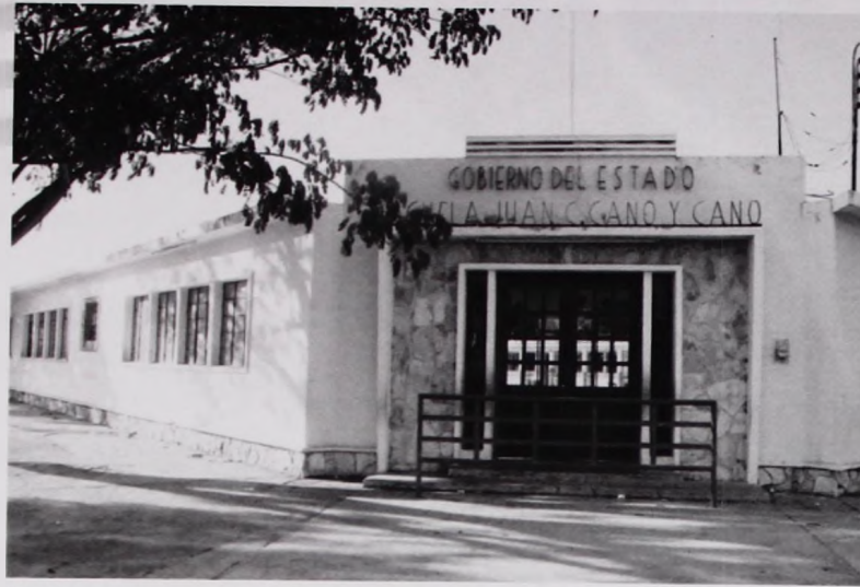
Foto No. 1. Acceso y fachada
