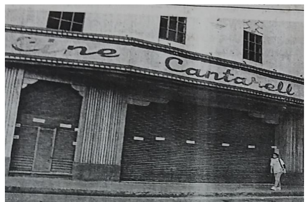
El Ayuntamiento detiene trabajos de demolición Diario de Yucatán, febrero 27 de 1997
