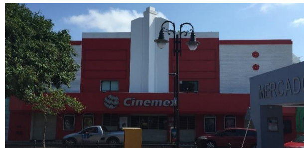
Fotografía: IGGH, junio de 2018 Vista actual
