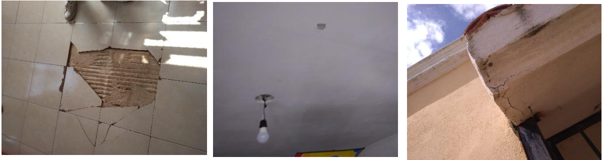
IMG 29 Desprendimiento de acabados, losetas y grietas. Fuente: Cyndy Alvarado Leyva
