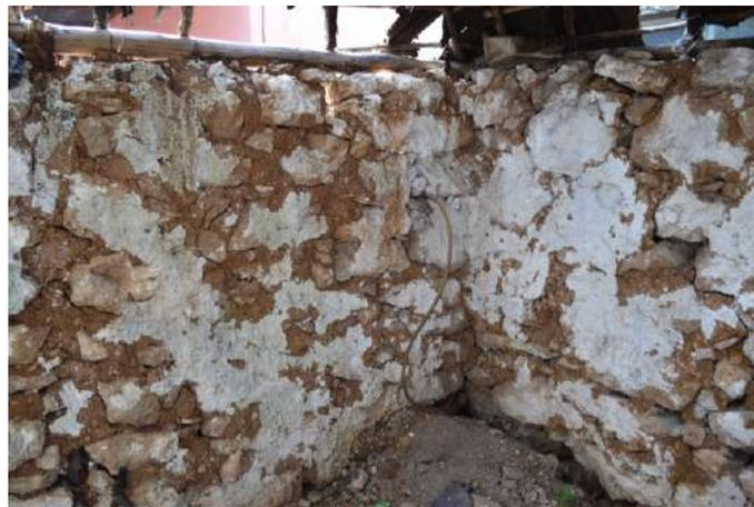
Figura 56. Acabado interior con palcum en una casa maya con muros de mampostería en Xcunyá
