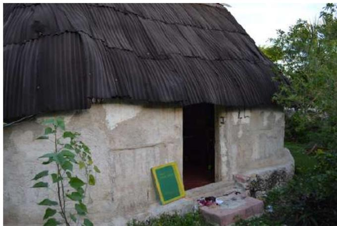
*Figura 49. Palcum del exterior cubierto con mortero cemento-arena al exterior de una casa maya en Caucel*
