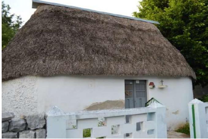
*Figura 53. Acabado exterior con aplanado de mortero en una casa maya de Cuzel*
