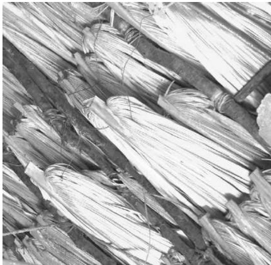
Figura 18. Detalle de uniones entre elementos de la estructura portante por medio de bejuco
