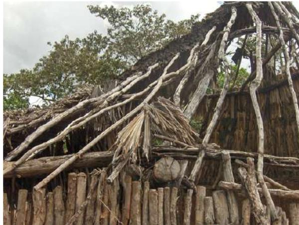
*Figura 68. Cubierta de palma de guano grandes pérdidas del material envolvente*
