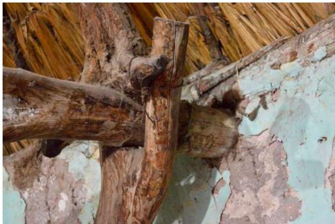
Figura 19. Detalle del asentado del baalo sobre el horcón
