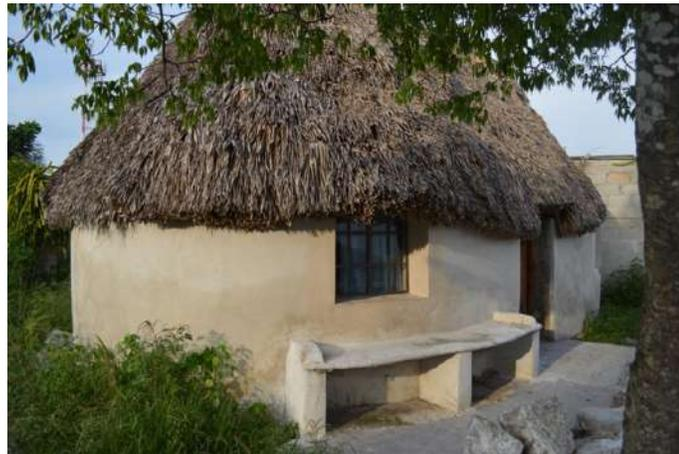
*Figura 54. Acabado exterior con aplanado de mortero en una casa maya de Sierra Papacal*
