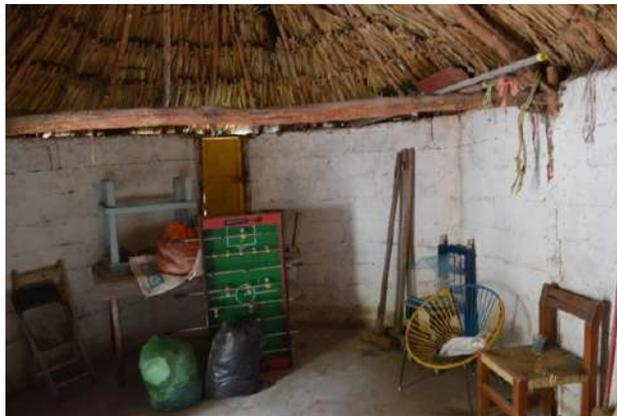
*Figura 58. Horcón embebido en muros de block en una casa maya de Cholul*
