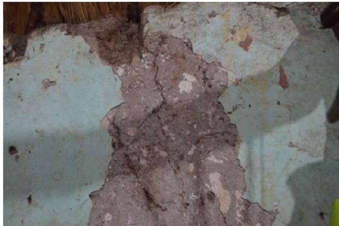
*Figura 48. Palcum del interior cubierto con mortero cemento-arena al interior de una casa maya en Caucel*
