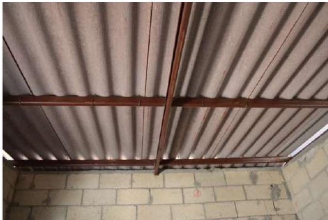
*Figura 35. Cambio total de la estructura portante superior de una casa maya en Cauce*
