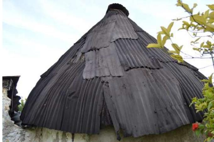
*Figura 65. Cubierta con Lámina de cartón con deterioros menores*
