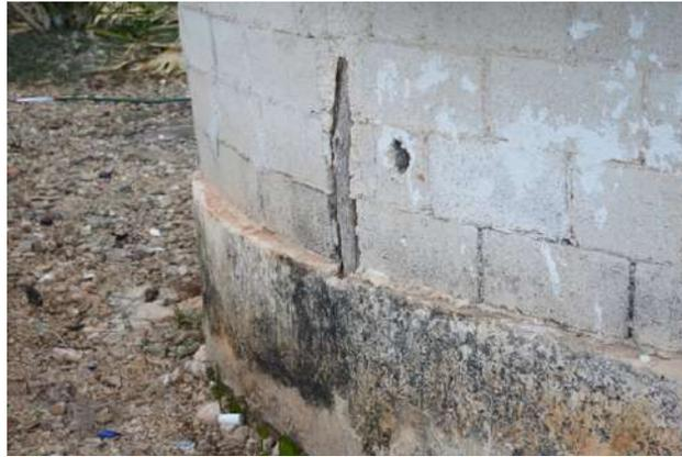
*Figura 57. Detalle de desplante de muro de block sobre el rodapié en una casa maya de Caucel*
