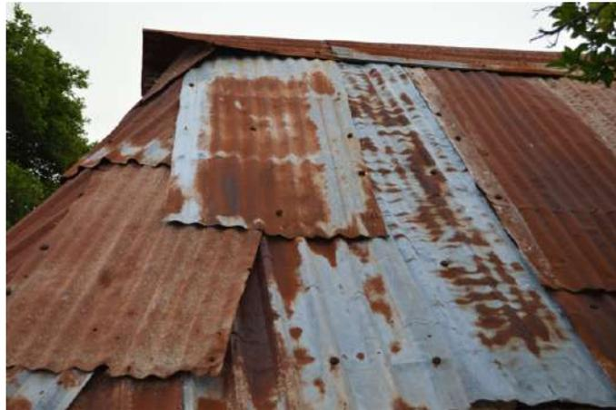
*Figura 66. Cubierta con lámina de zinc con deterioros regulares*
