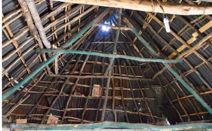
*Figura 30. Casa maya con elemento inclinado que conecta del moy hasta el holnah-ché en Xcunyá*
