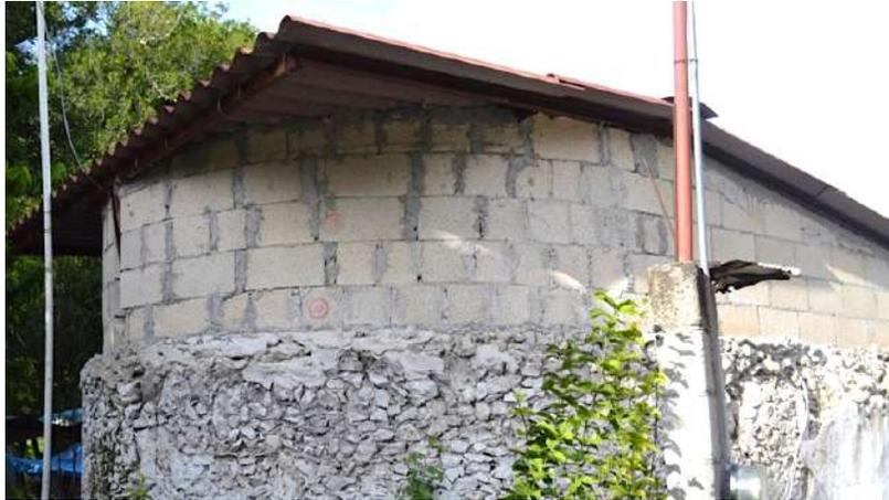
*Figura 36. Detalle del exterior de la cubierta nueva de una casa maya en Caucel*
