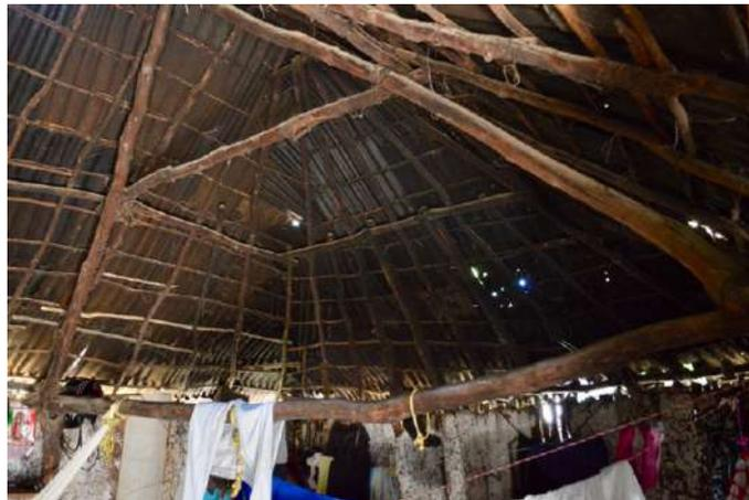
*Figura 29. Casa maya de planta rectangular sin modificaciones en la estructura portante en Yaxnic*
