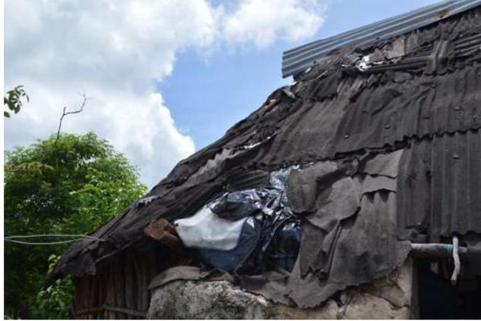
*Figura 67. Cubierta de lámina de cartón en pésimas condiciones con parches de bolsas de plástico y cartón*
