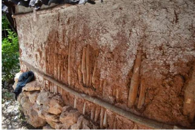
*Figura 45. Deterioro parcial del palcum exterior en una casa maya de Yaxnic*
