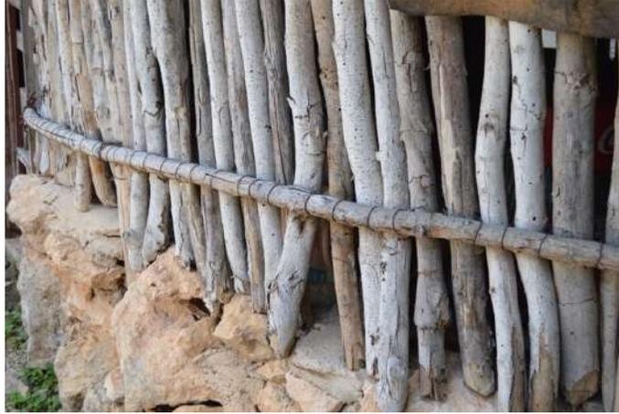
*Figura 43. Muro de bahareque rigidizado por medio del halabche en una casa maya de Yaxnic*
