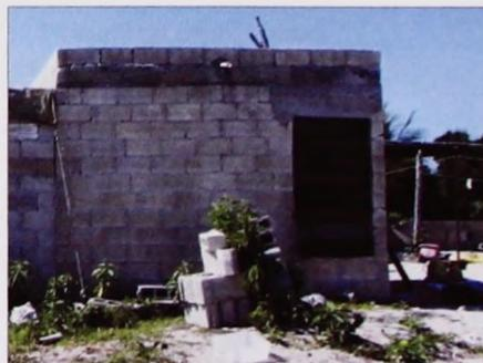
**Imagen 79.** Materiales de construcción de la edificación 2 de una vivienda C2 tipo "d".
