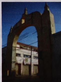
Figura 62 Arco del Puente. Foto: Tapia, 2010
