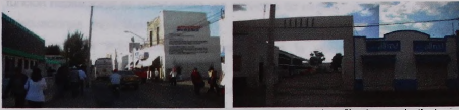
Figuras 91 y 92. Calle 50 entre 65 y 67: Alteraciones en el perfil urbano y la tipología arquitectónica original debido al establecimiento de terminales de transporte.
