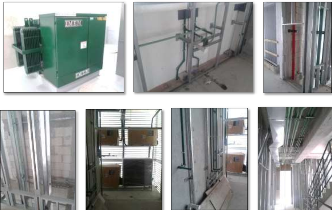
Figura 22. Instalaciones en el proyecto. (Fotografías propias).
