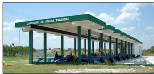
Figura 29. Vistas de la planta potabilizadora Mérida III. (Japay). (Obtenida el 20 ene. 2015).
