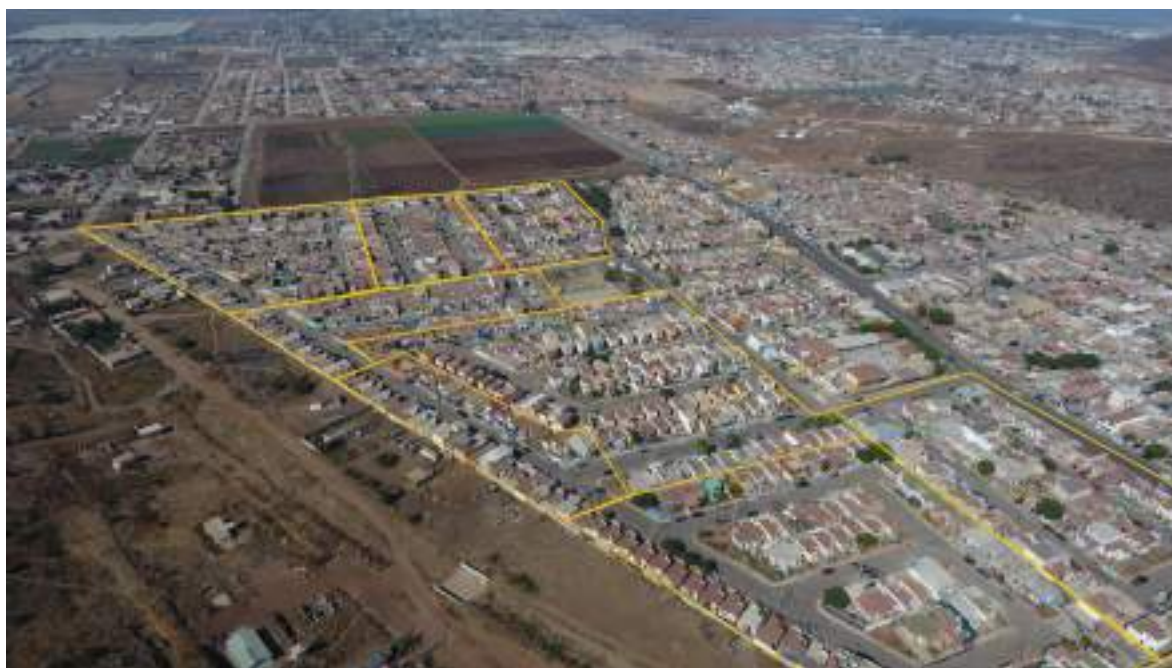
Figura 52. Vista panorámica del caso B-Villas del Rey I
